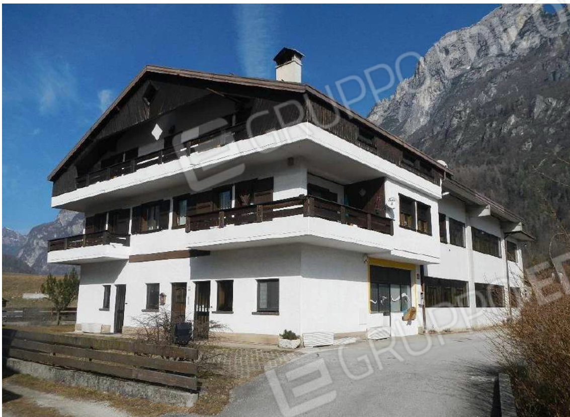
Foto 1. Vista generale fabbricato lato sud ovest
