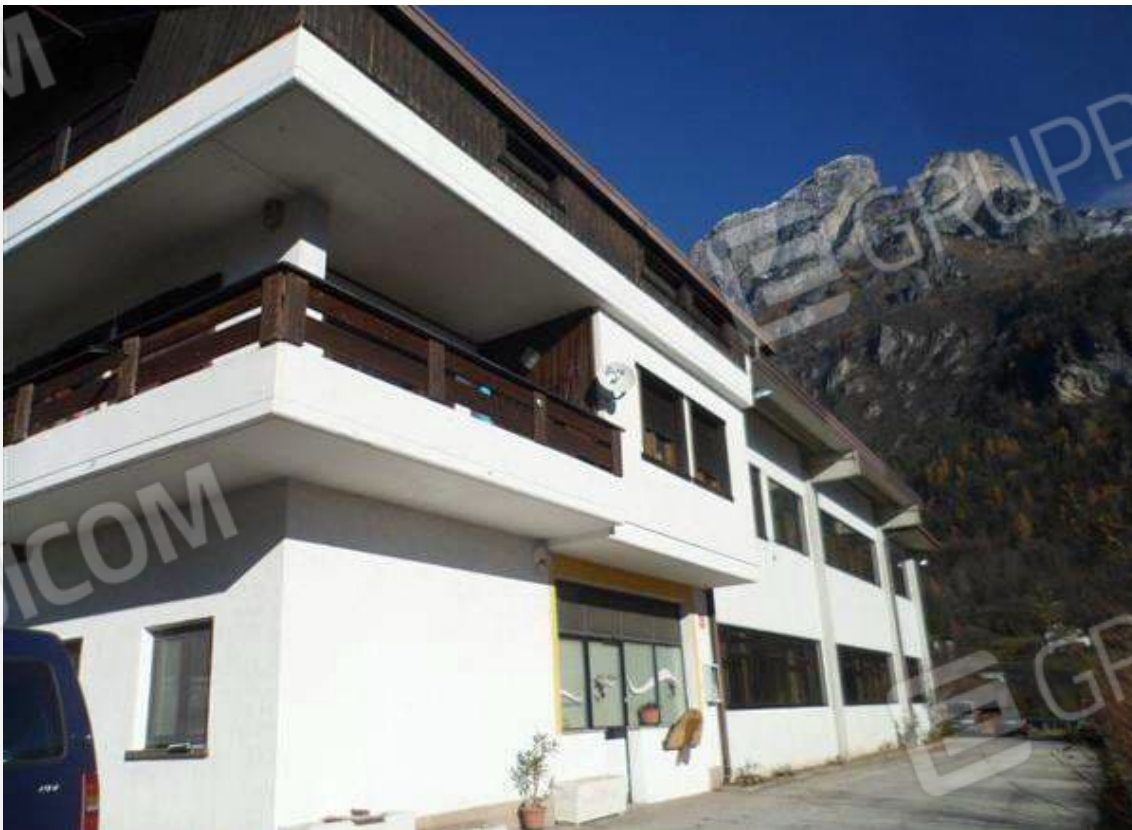
Foto 4. Vista generale fabbricato lato sud
