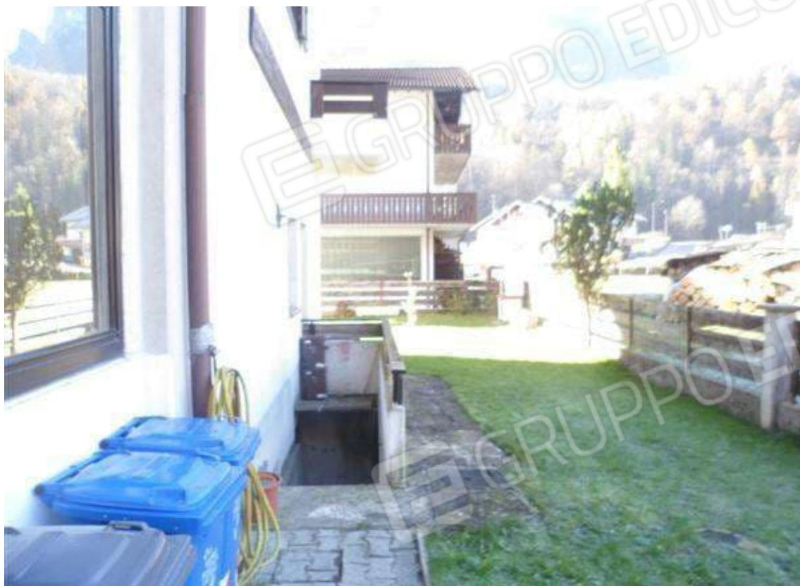
Foto 5. Dettaglio ingresso cantina su sottostrada
