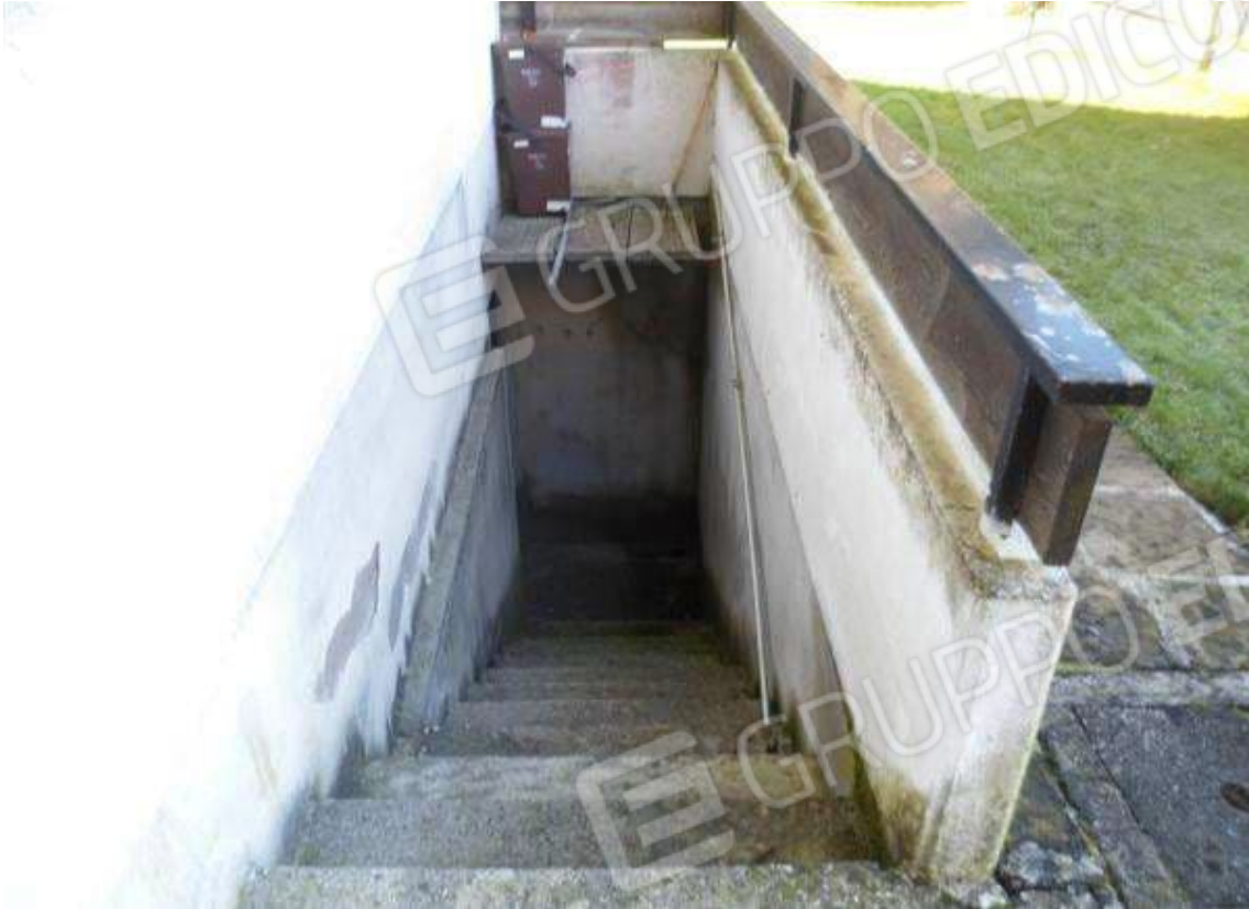
Foto 22. Ingresso cantina su sottostrada
