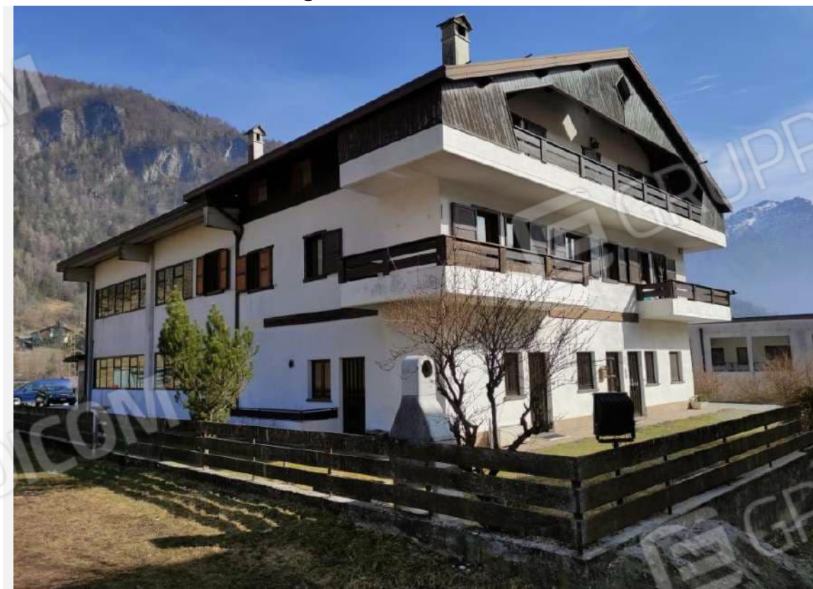
Foto 2. Vista generale fabbricato lato ovest
