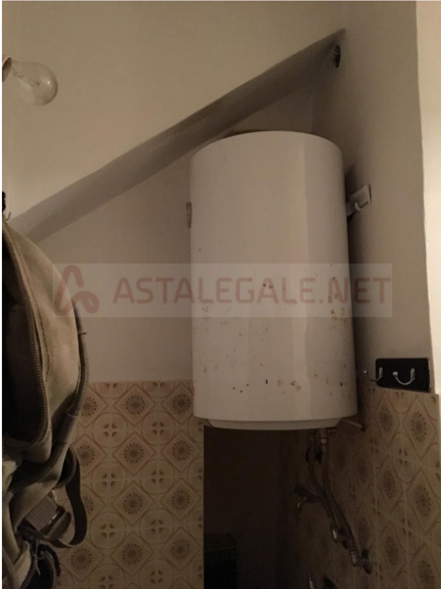
Vista d'interni – antibagno piano primo
