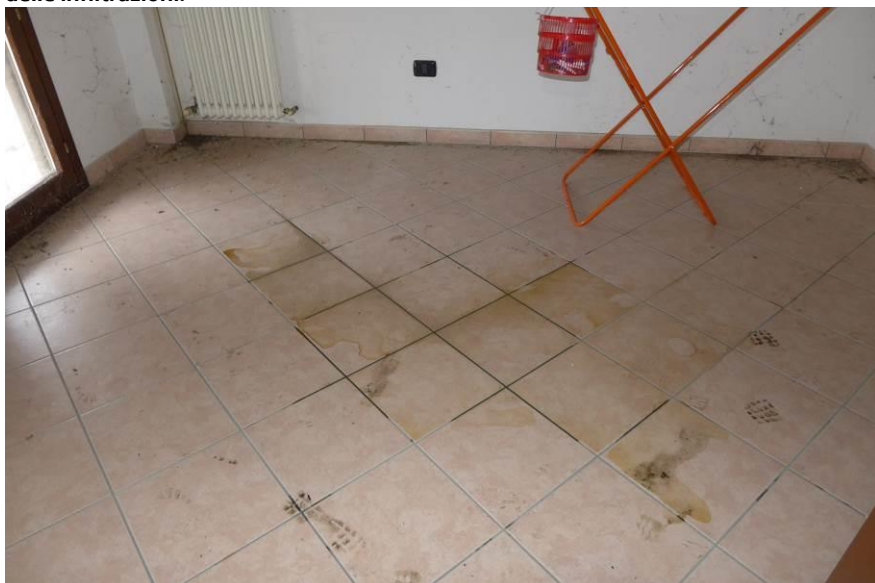
Figura 4: viste delle infiltrazioni.
