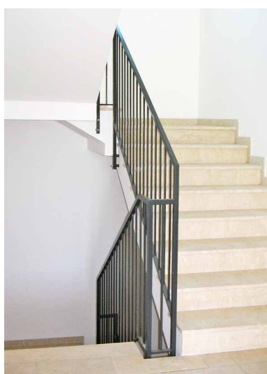
F _ Scala interna
