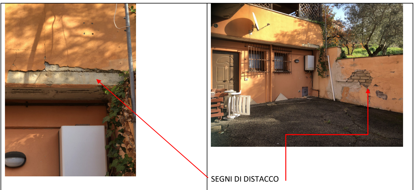
FOTOGRAFICHE SCATTATE DURANTE IL SOPRALLUOGO DEL 10-01-2025
