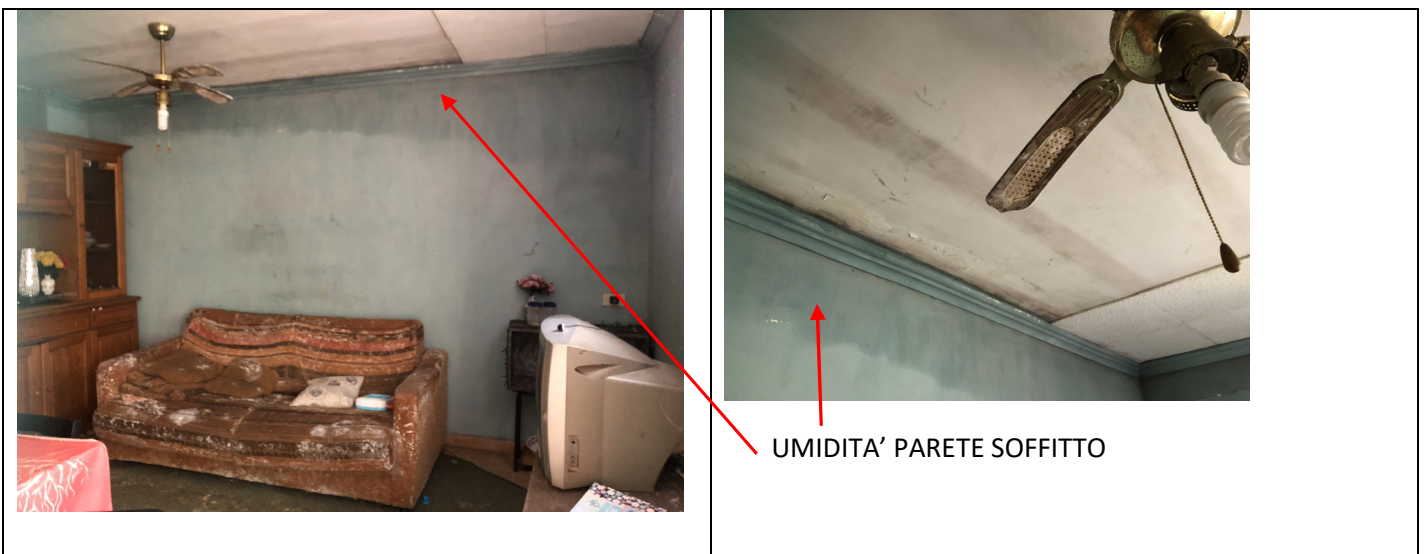
FOTOGRAFICHE SCATTATE DURANTE IL SOPRALLUOGO DEL 10-01-2025
