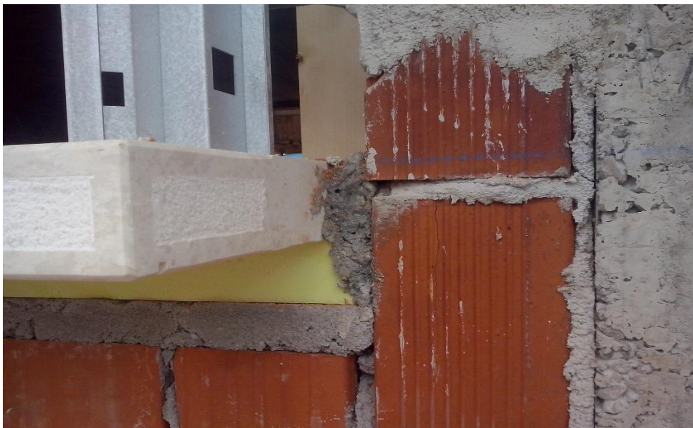
Particolare Isolamento banchina in marmo (polistirene cm 5)
