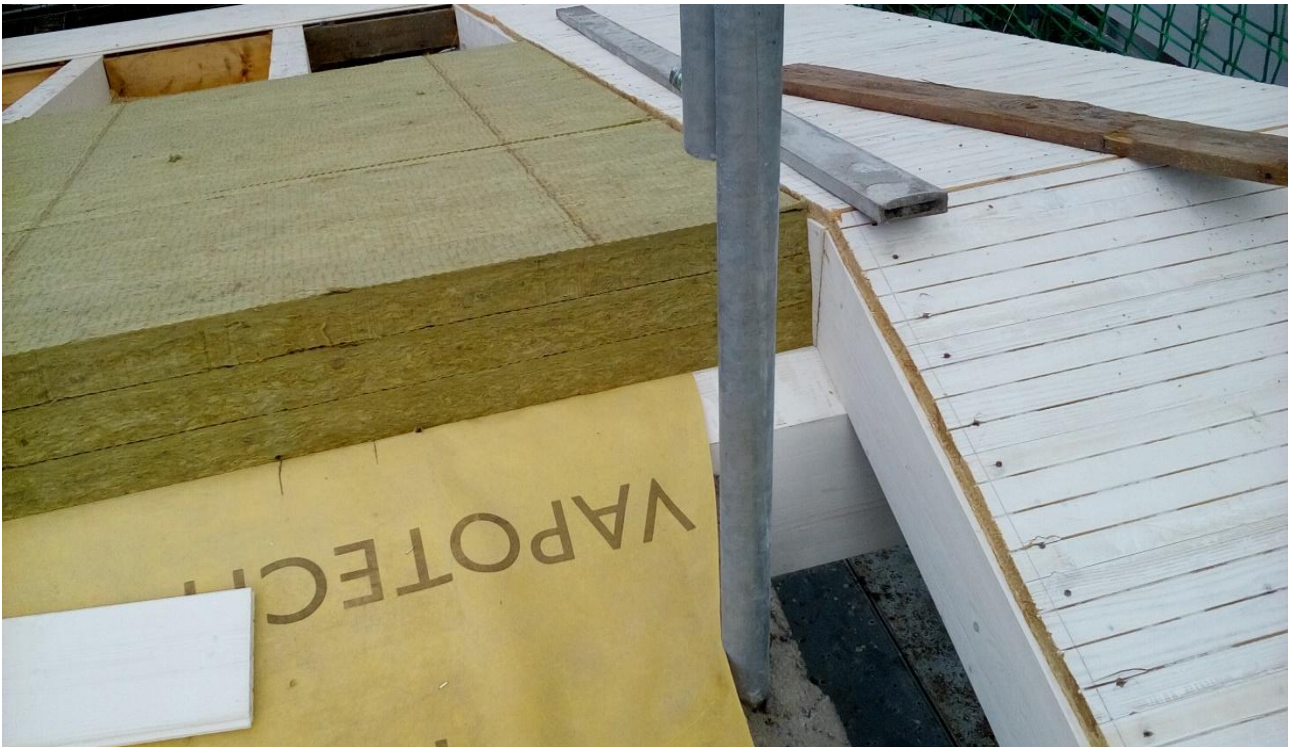
LISTELLATURA PER TETTO VENTILATO E TELO TRASPIRANTE IMPERMEABILE
