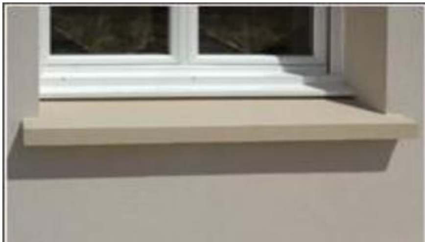
Particolare Isolamento banchina in marmo (polistirene cm 5)
