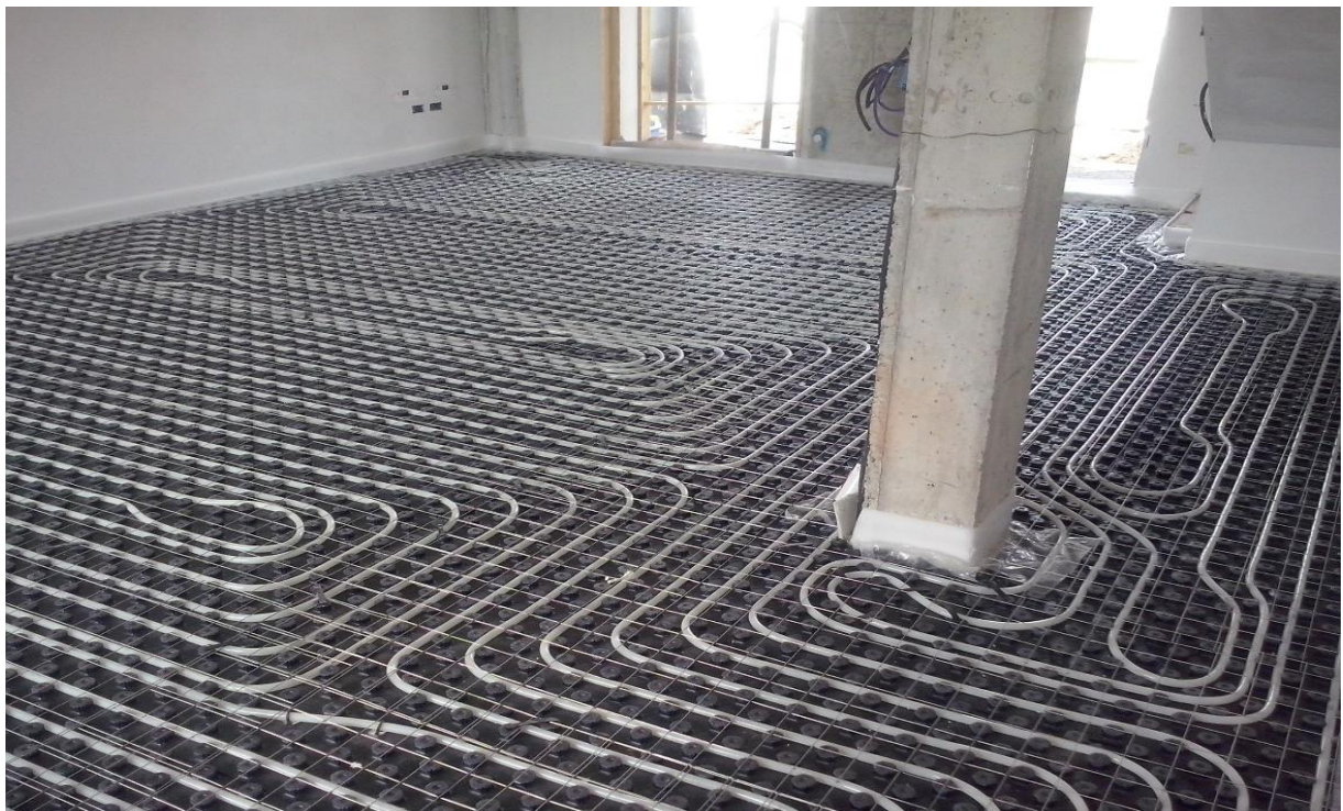
Particolare pannelli radianti spessore sopra tappo cm 4
