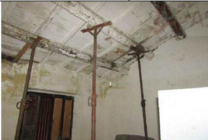
Foto 3 – Interno Lotto 1 - Corpo 1 Casa Rurale -
