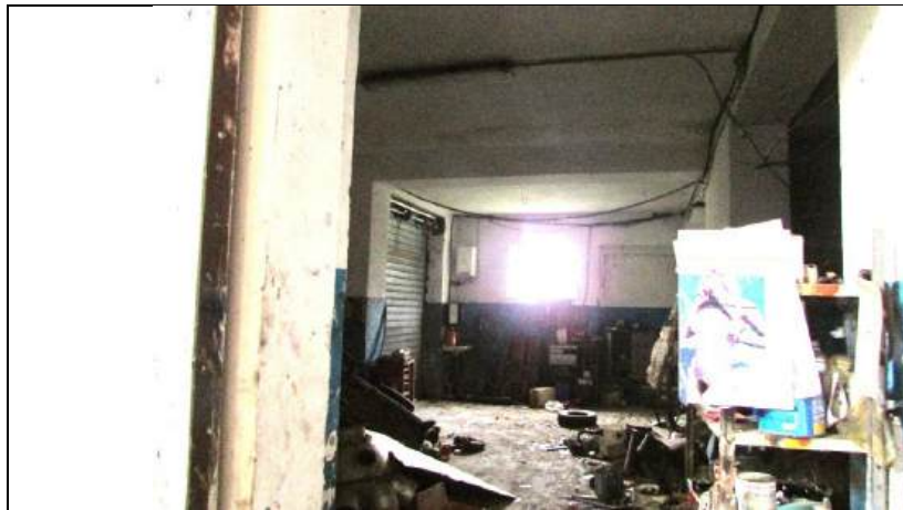
Foto 1 – Interno Lotto 1 - Corpo 1 Casa Rurale -
