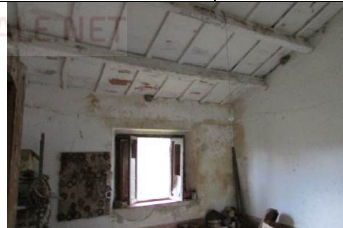
Foto 4 – Interno Lotto 1 - Corpo 1 Casa Rurale -
