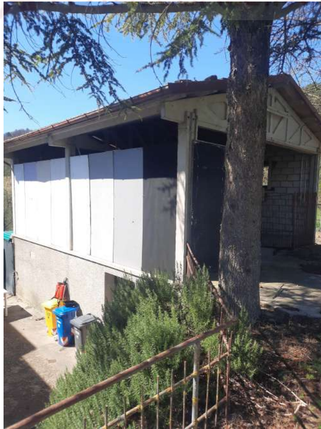
14 – VISTA DEPOSITO E TETTOIA IN CORPO SEPARATO
