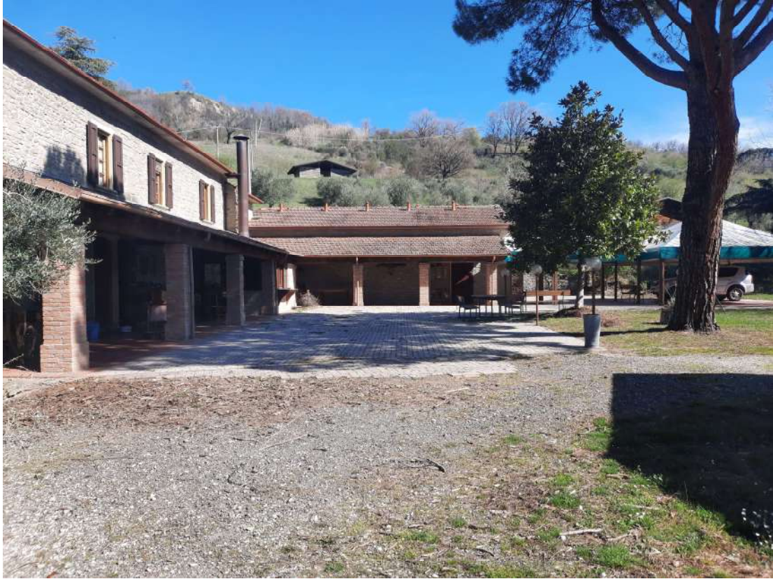
6 VISTA LATO SUD-SUD-EST FABBRICATO PRINCIPALE
