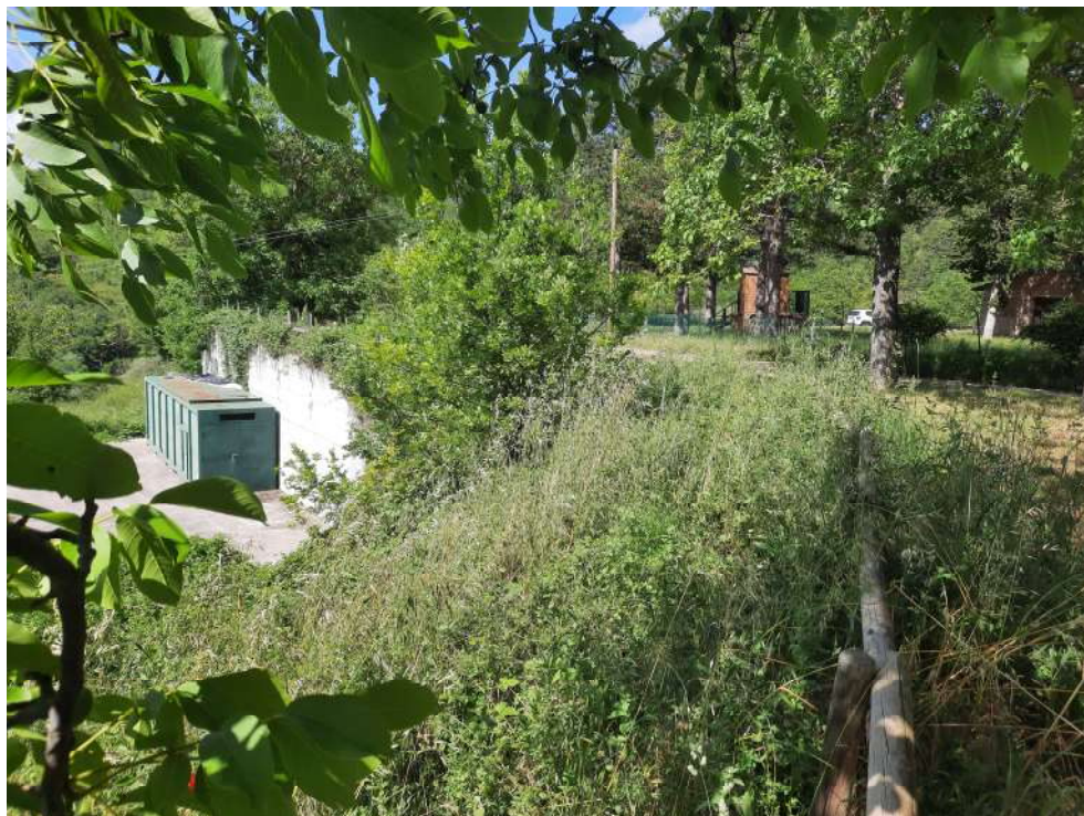
41 – VISTA TERRENI (CON OPERE PER IMPIANTO A BIOMASSA)
