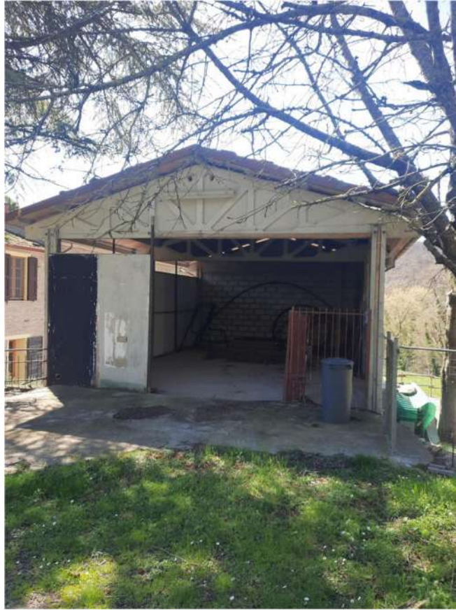
14 – VISTA DEPOSITO E TETTOIA IN CORPO SEPARATO
