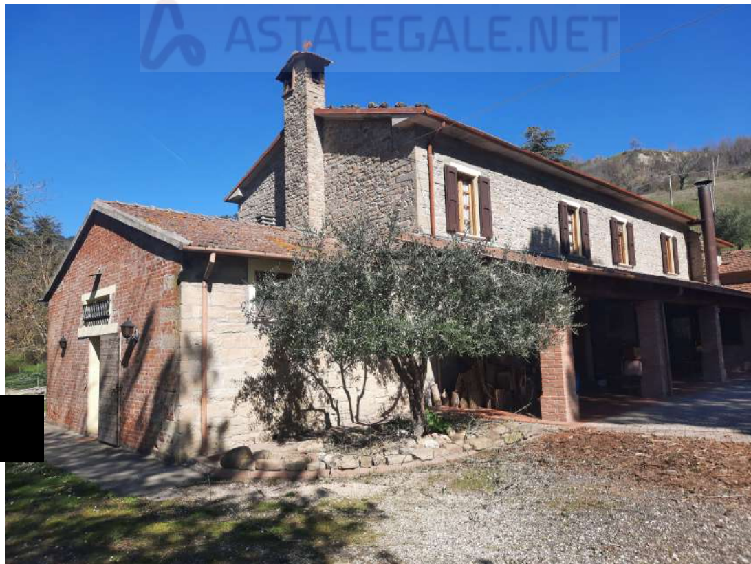
5 – VISTA LATO SUD –EST FABBRICATO PRINCIPALE
