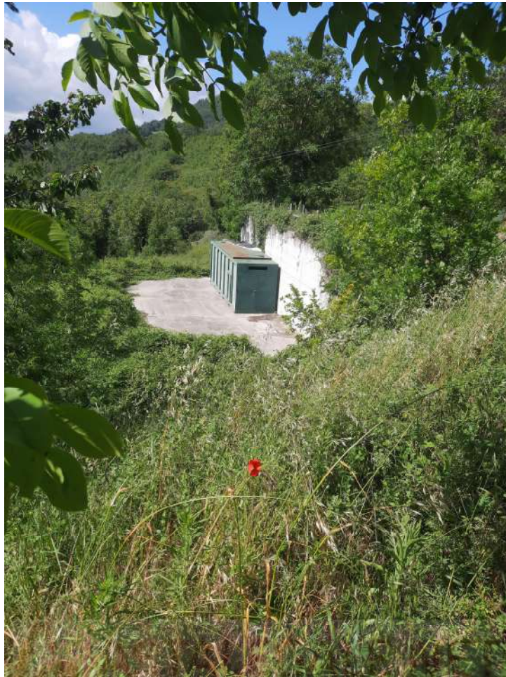
40 – VISTA TERRENI (CON OPERE PER IMPIANTO A BIOMASSA)
