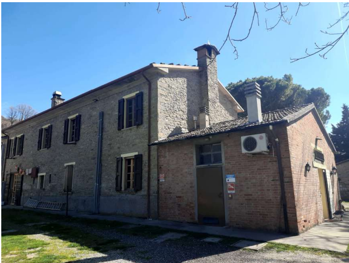
8- VISTA LATO NORD-OVEST FABBRICATO PRINCIPALE
