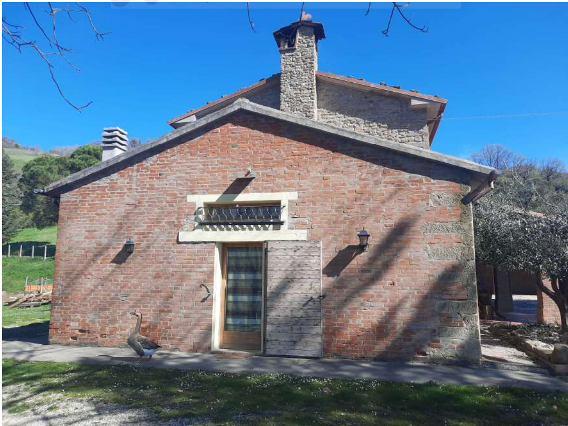
7- VISTA PROSPETTO SUD FABBRICATO PRINCIPALE
