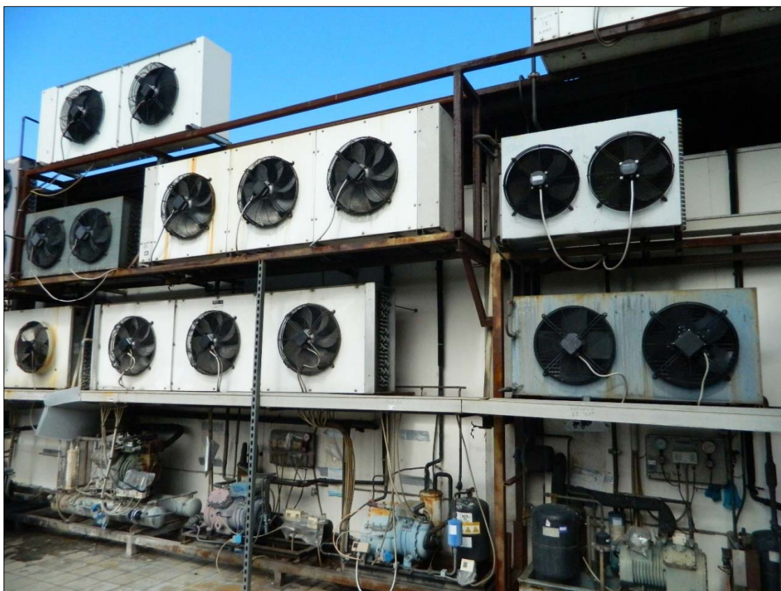
FOTO N. 31: PIANO PRIMO -particolare terrazza zona motori-
