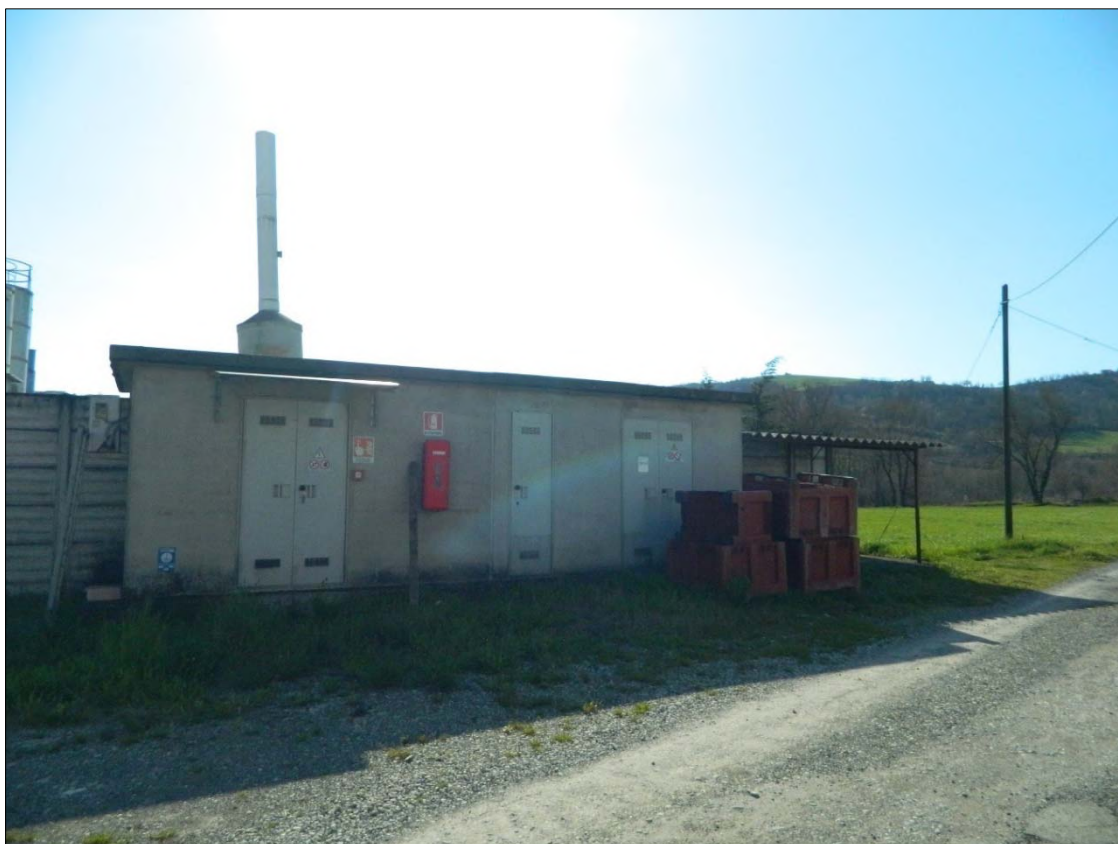
FOTO N. 44: PIANO TERRA -particolare cabina ENEL-
