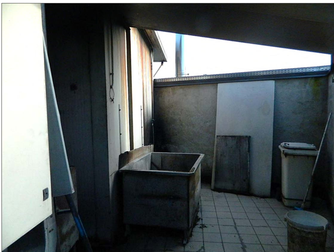
FOTO N. 32: PIANO PRIMO -particolare "zona affumicatura"
