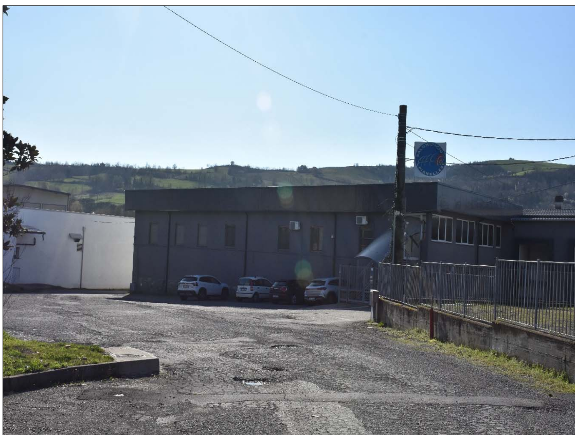
FOTO N. 46: PIANO TERRA prospetti (particolare ingresso allo stabilimento)
