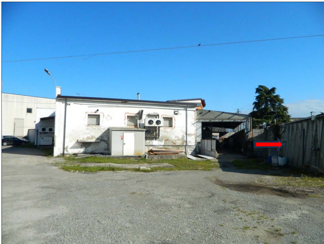
FOTO N. 41: PIANO TERRA -vasca cisterna acqua-
