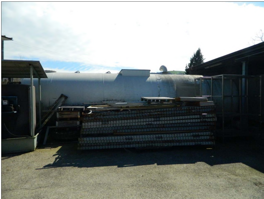
FOTO N. 43: PIANO TERRA -particolare box antincendio-
