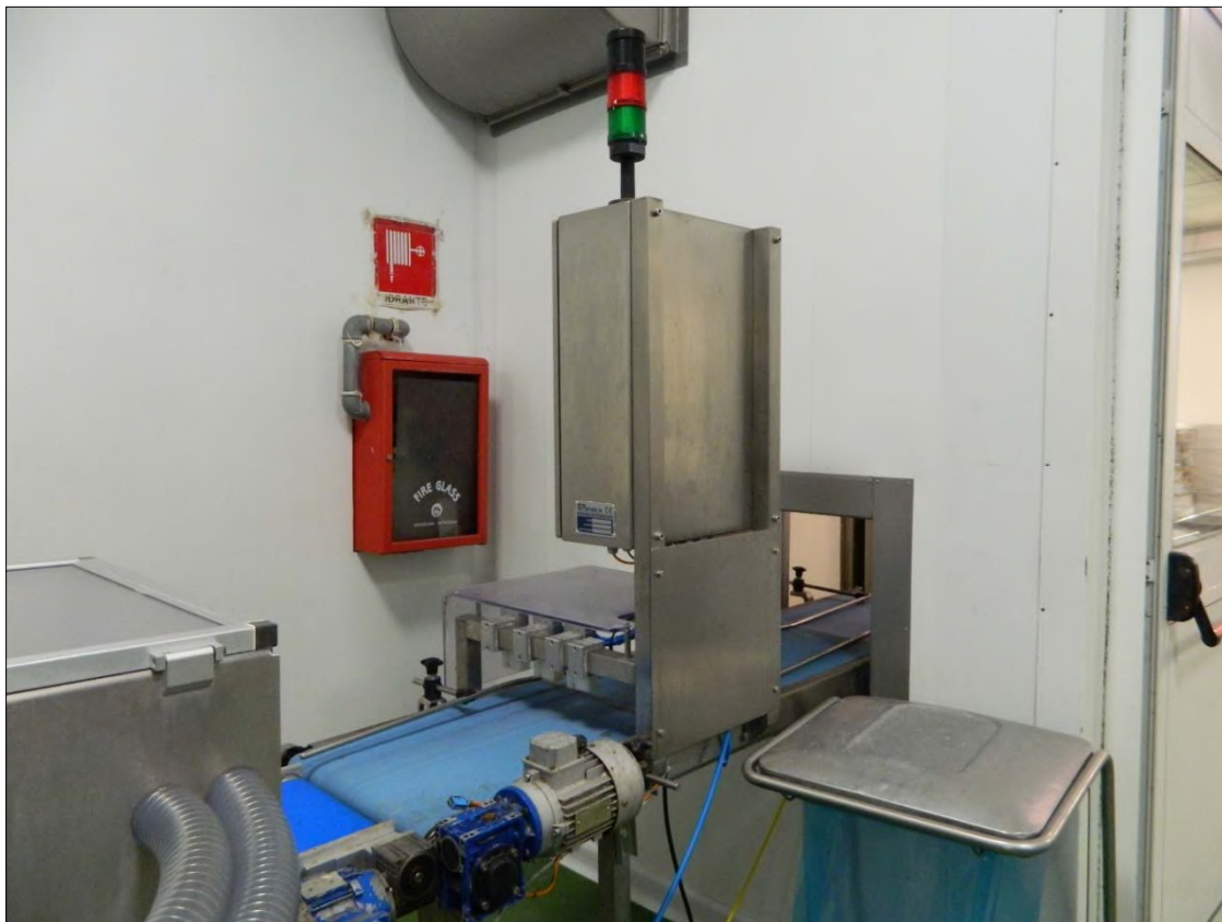
FOTO N. 13: PIANO TERRA -part. Allineatori fra "camera bianca" e "confezionamento"
