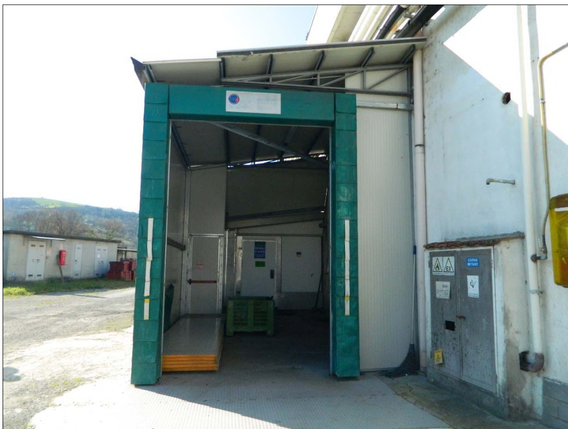
FOTO N. 1: PIANO TERRA -particolare ingresso scarico materie prime
