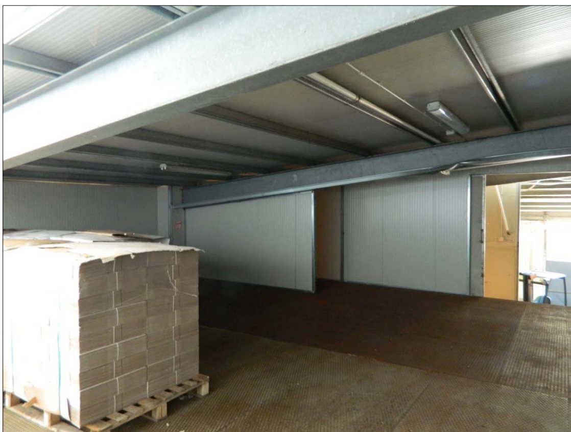
FOTO N. 34: PIANO PRIMO -particolare "soppalco-deposito"
