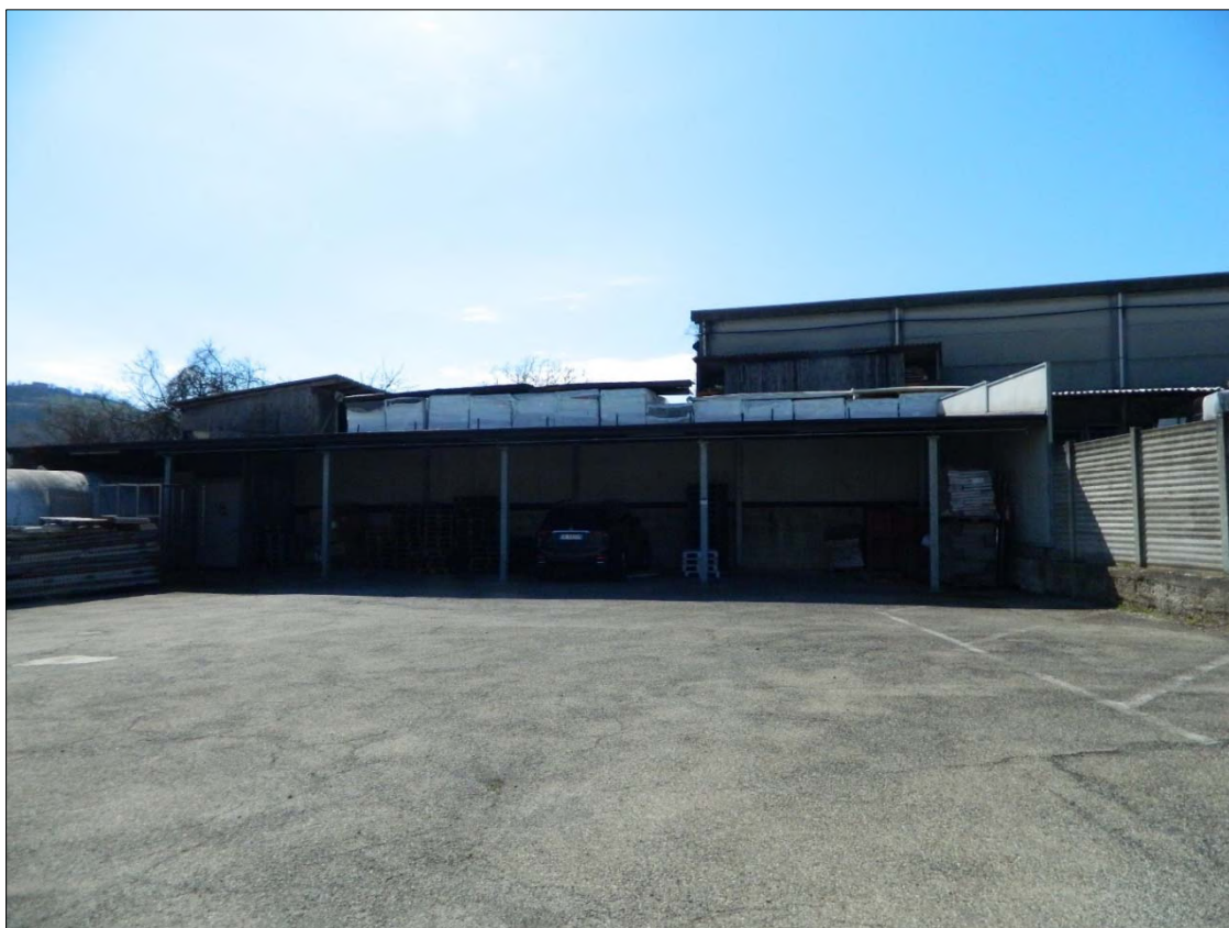
FOTO N. 42: PIANO TERRA -particolare tettoia ricovero mezzi-
