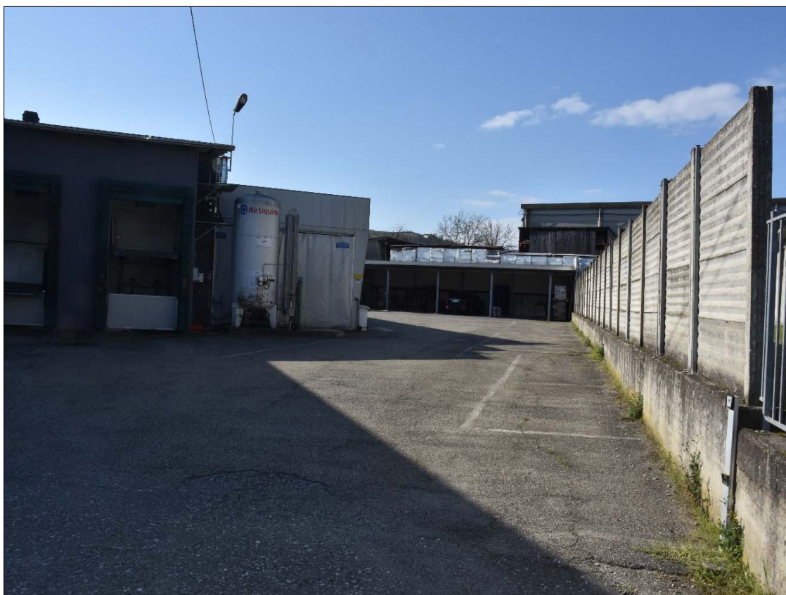
FOTO N. 47: PIANO TERRA prospetti, sullo sfondo la tettoia ricovero mezzi
