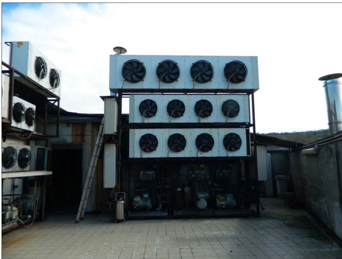
FOTO N. 30: PIANO PRIMO -particolare terrazza zona motori-
