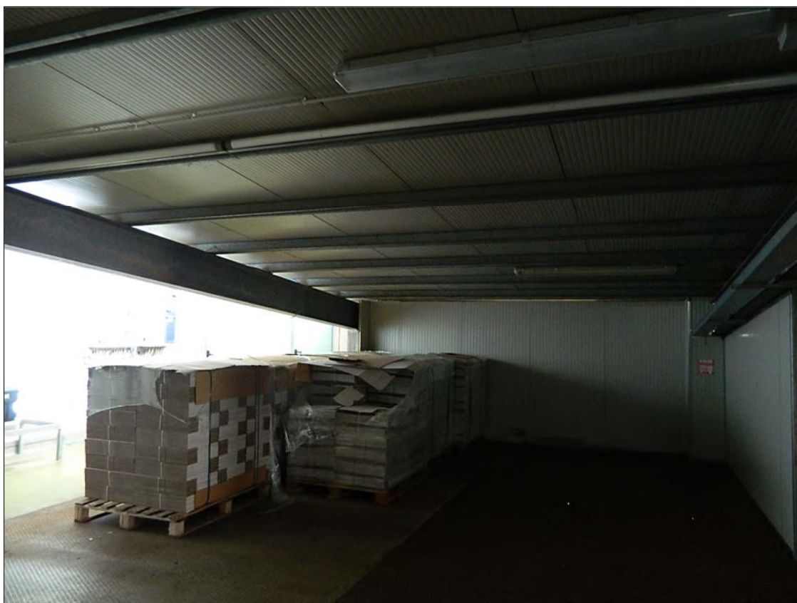
FOTO N. 33: PIANO PRIMO -particolare "soppalco-deposito"
