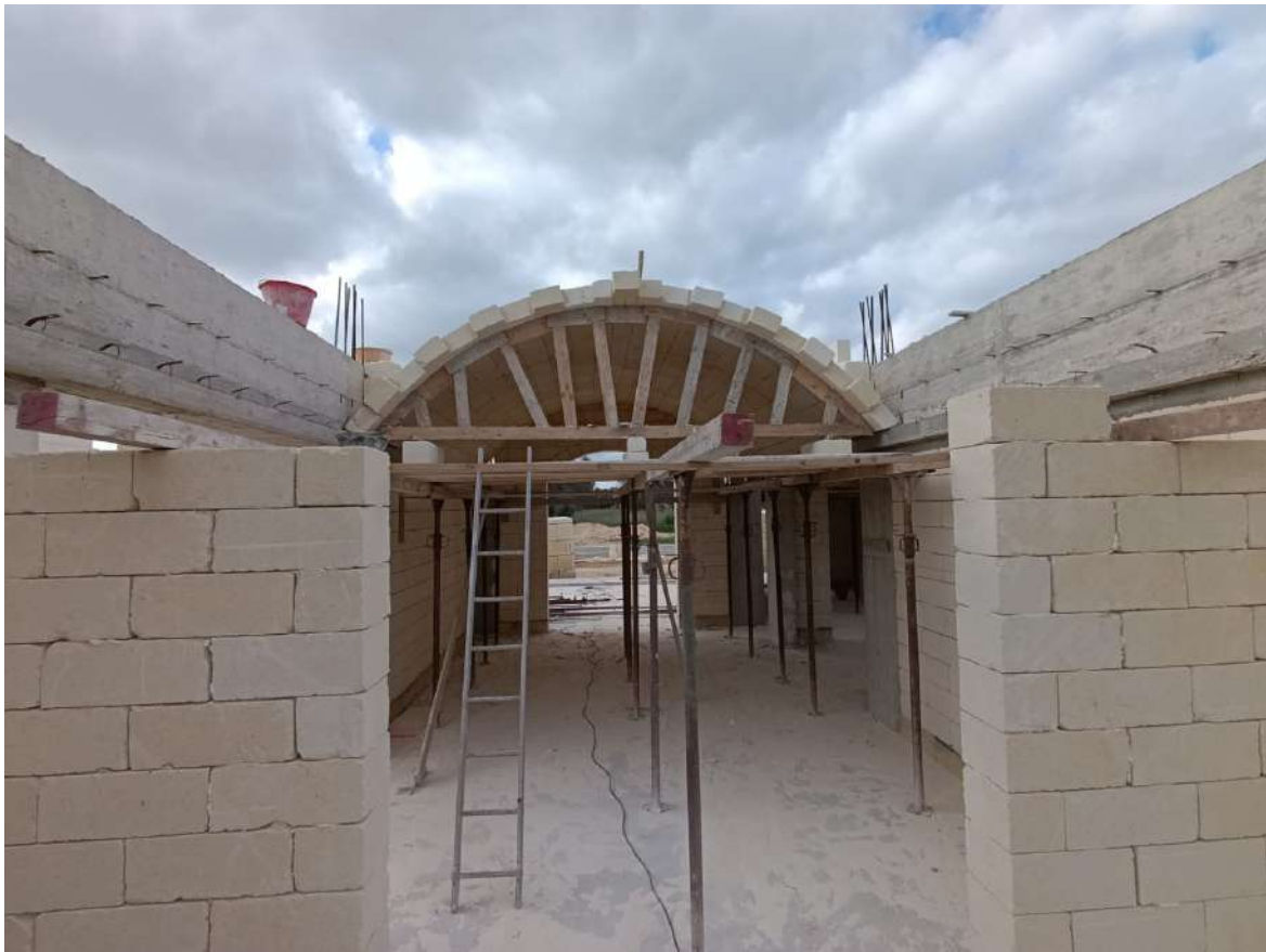
muratura esterna in tufo a doppia paramento
