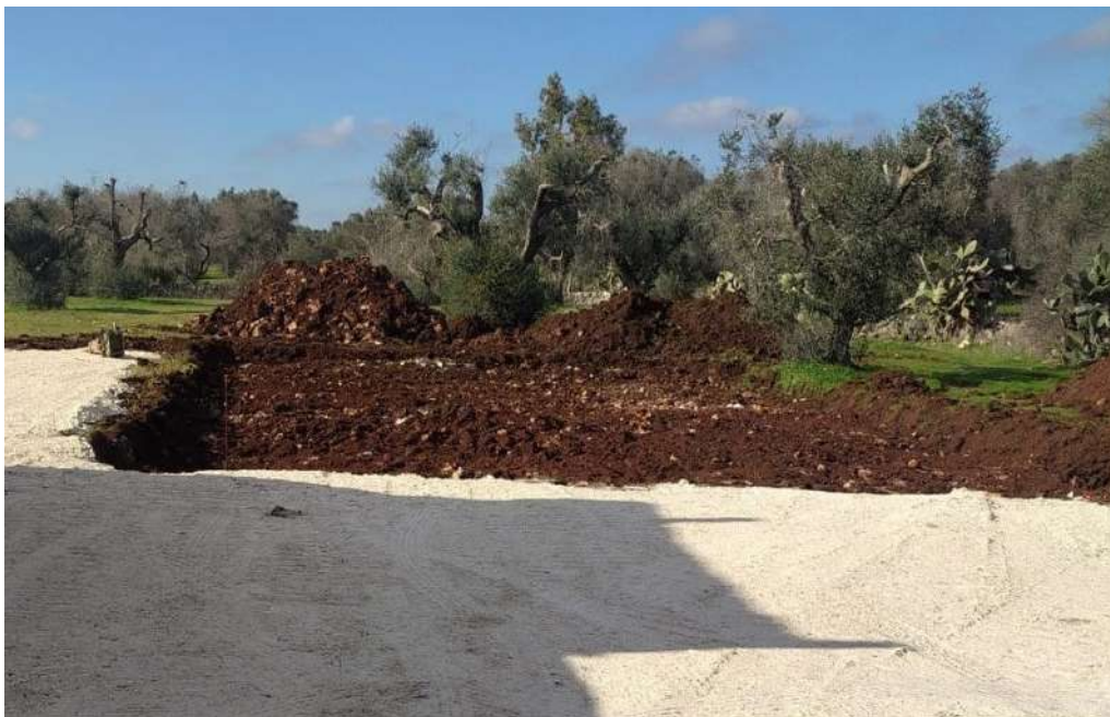
sbanramento per piano posa fondazioni
