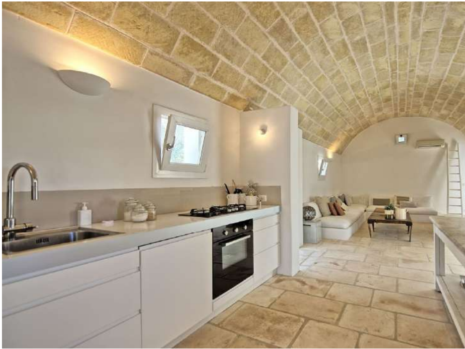
tipologia di copertura voltata in tufo finita
