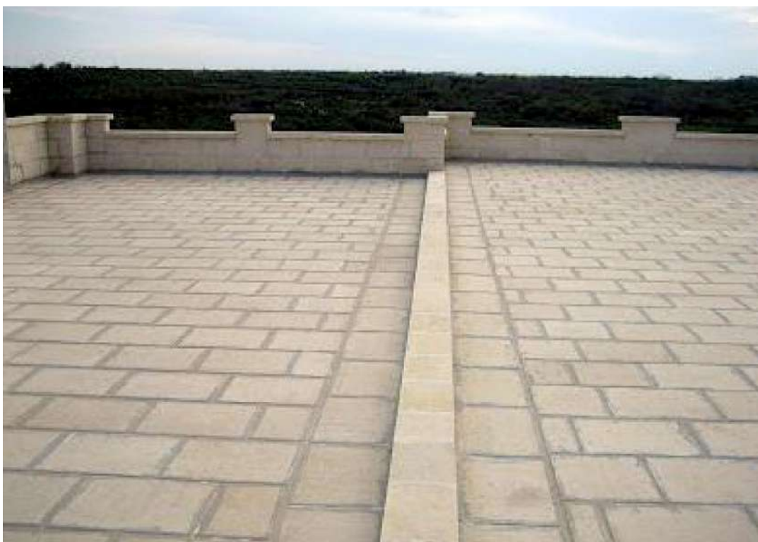
Vista finale impermeabilizzazione coperture
