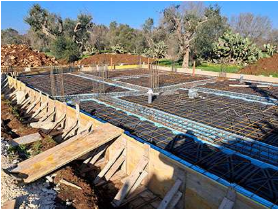
Getto travi di fondazione e vespaio areato
