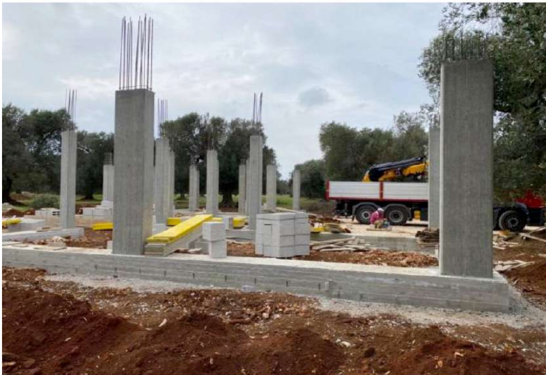
travi fondazioni e pilastri in cemento armato
