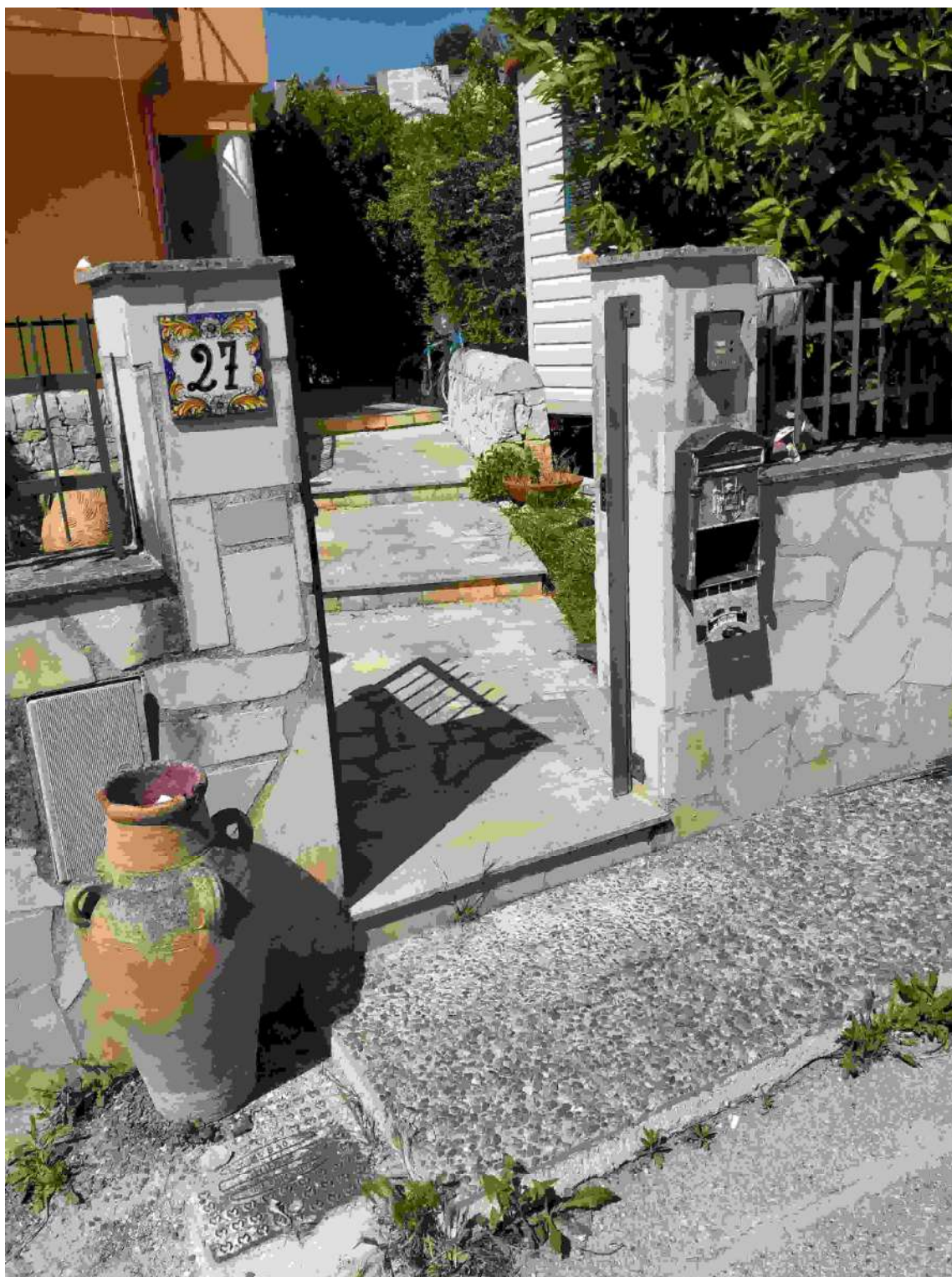
Foto n. 2 – Particolare ingresso dalla via Siracusa n.27.
