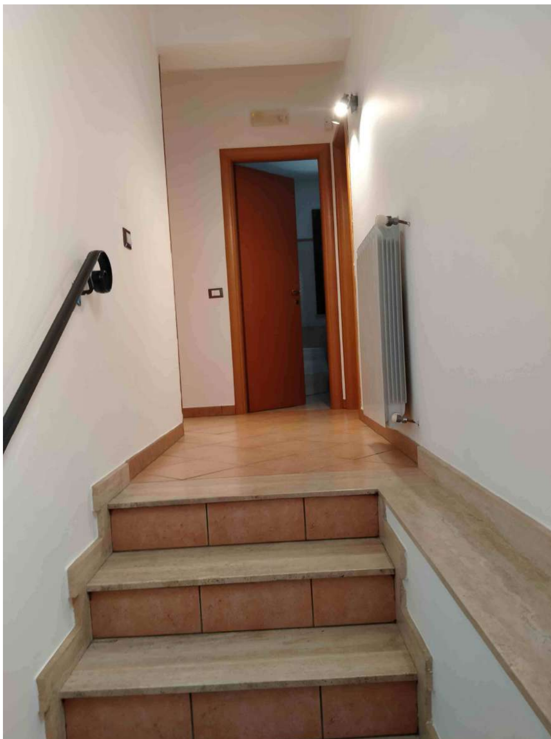
Foto n.12 – Rampa scale accesso primo piano.
