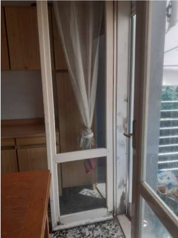
5. Interno: dettaglio infisso
