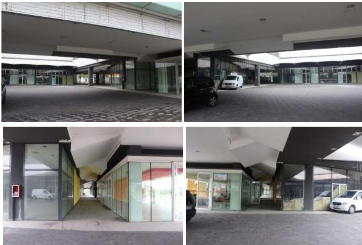
Foto fabbricato galleria – anno 2020
