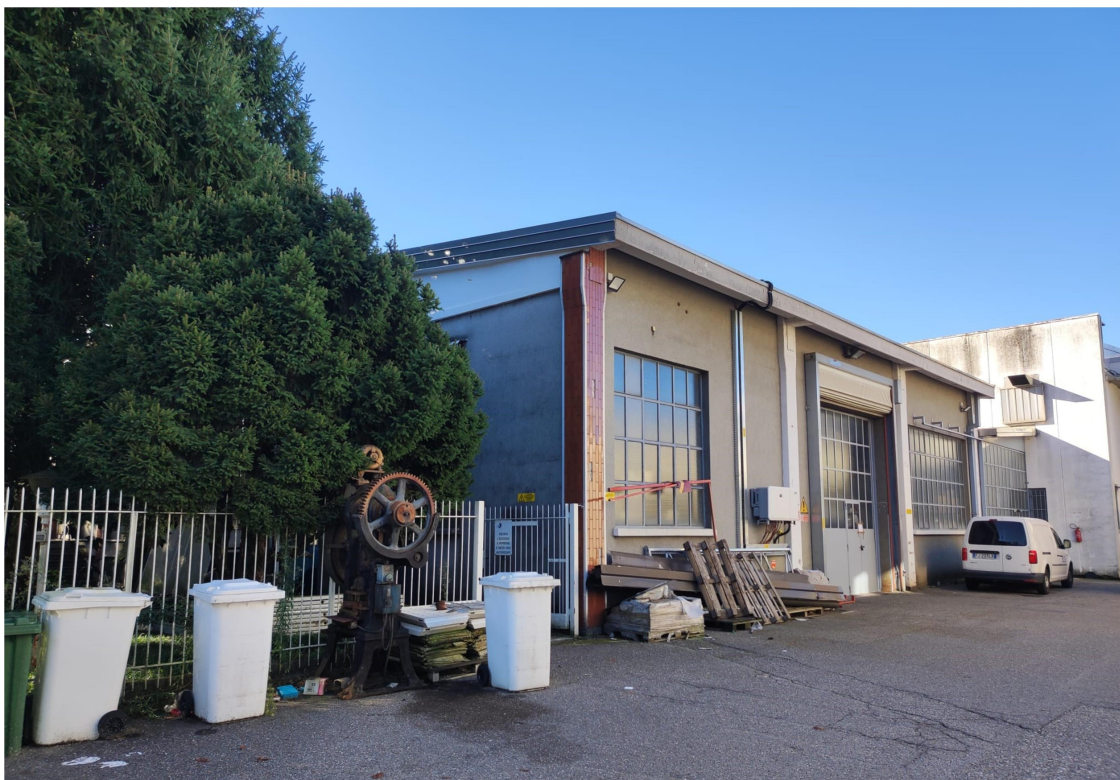
Vista prospettica capannone su cui è installato l'impianto
