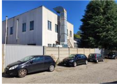
Vista da strada privata laterale
