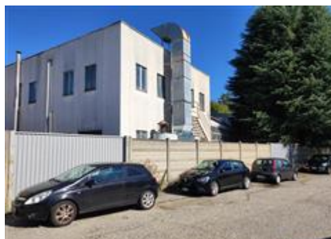
Vista da strada privata laterale
