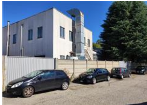
Vista da strada privata laterale
