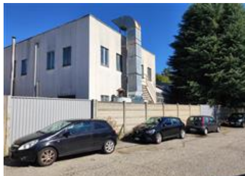
Vista da strada privata laterale
