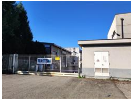
Vista frontale dal parcheggio esterno
