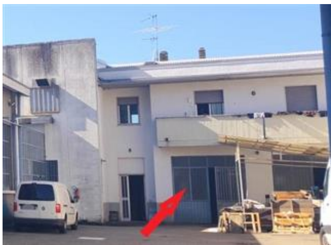
vista esterna e ubicazione
