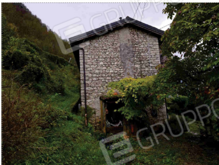
Foto n. 3 Fg. 81 mapp. 524 - Fabbricato, prospetto nord-ovest
