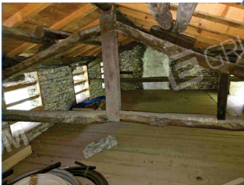
Foto n. 12 - C.F. Fg. 81 mapp. 524 - Piano secondo, soffitta
