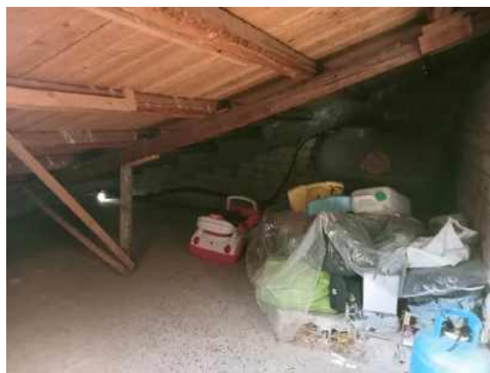
Foto 2 – deposito sottotetto piano 3
