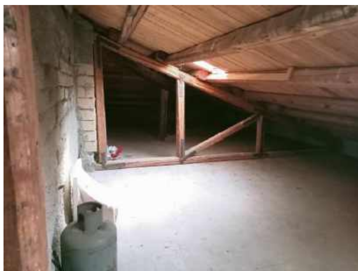
Foto 1 – deposito sottotetto piano 3
