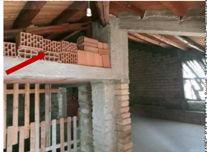
Foto 6 – deposito sottotetto piano 4
