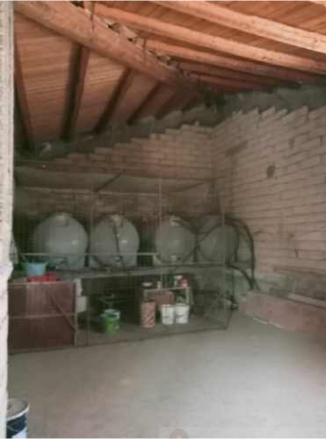
Foto 3 – deposito sottotetto piano 3
