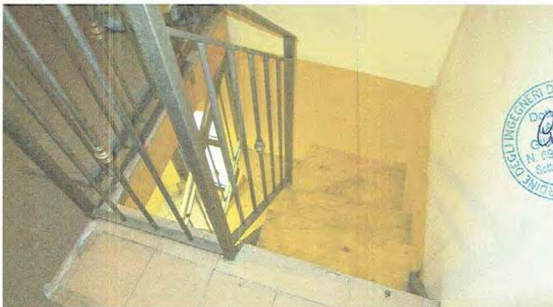
Foto n.13 - Vano Scala (Ferro-Legno) (Comunicante con U.I. n.8)
