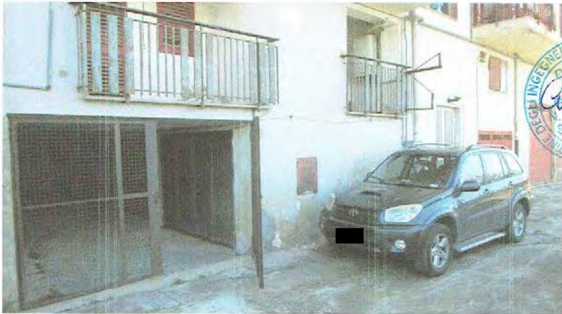
Foto n.29 - Prospetto Ovest (Cancello di Accesso)
