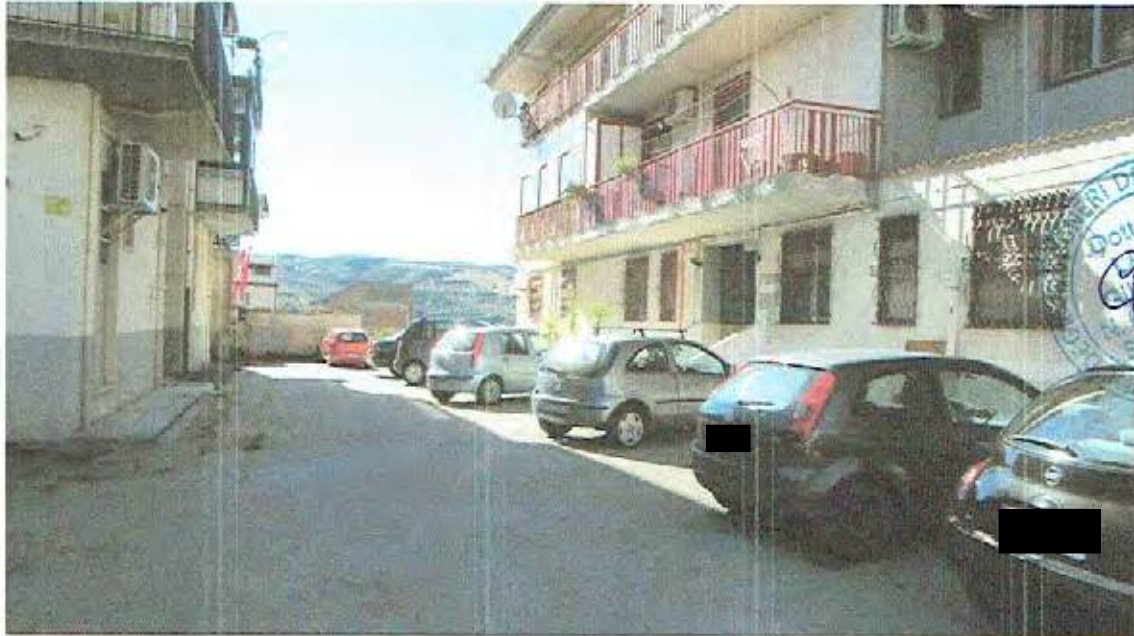
Foto n.03 - Prospetto Est (Piazzale di Accesso alla U.I.)
