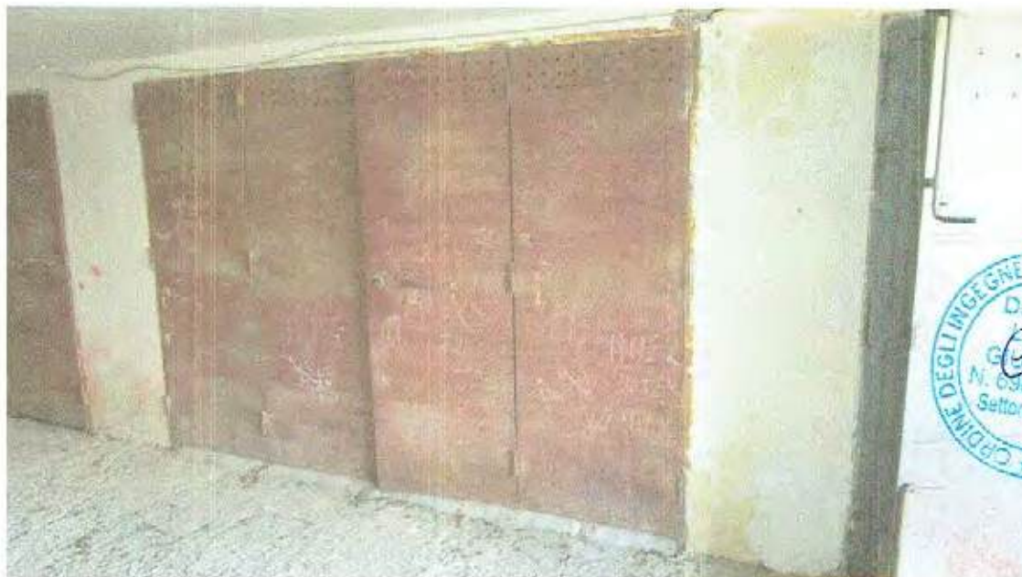
Foto n.37 - Unità Immobiliare n.5 (Piano S2 - Entrata Garage)
