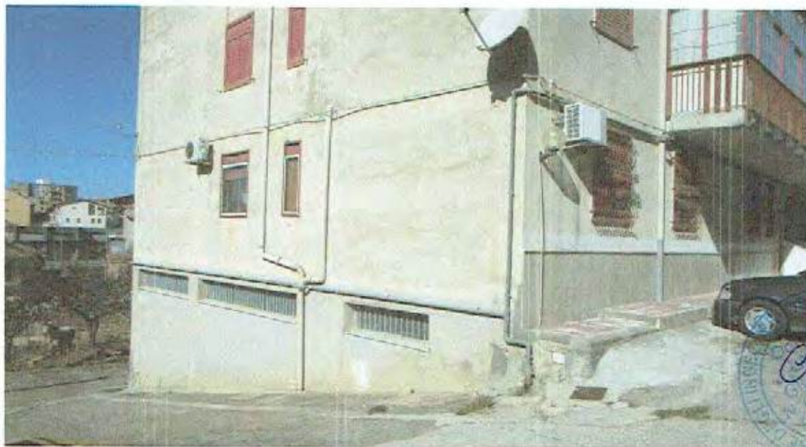
Foto n.02 - Prospetto Sud (Strada Pertinenziale di Accesso alla U.I.)
