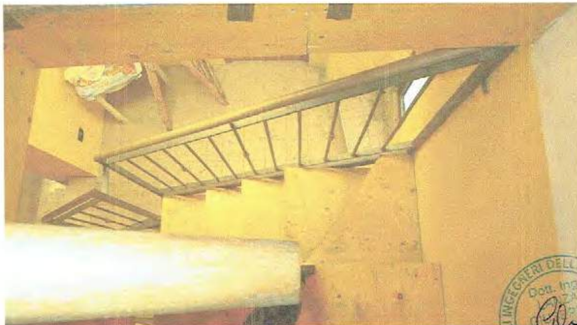
Foto n.08 - Vano Scala (Ferro-Legno) (Comunicante con U.I. n.9)
