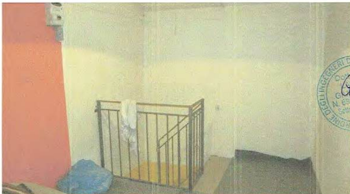
Foto n.11 - Camera da Letto (Lato Sud)
