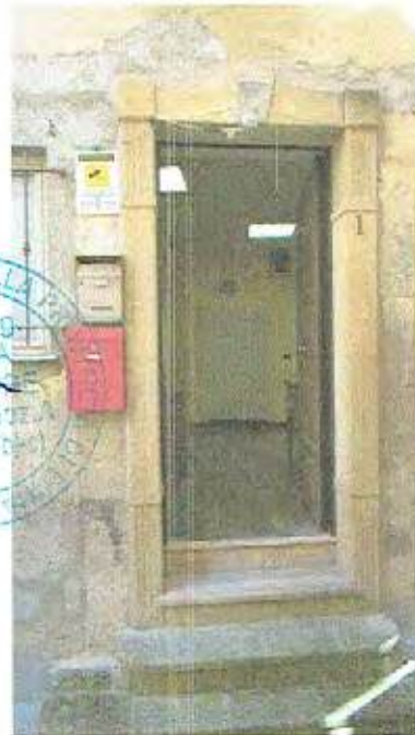
Foto n.17 - Prospetto Sud (Piano Terra - Entrata)
