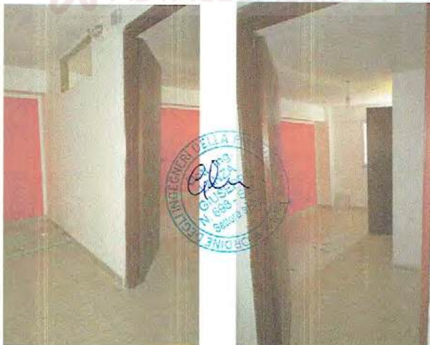
Foto n.10 - Vano Ingresso + Rip. e Vano Ufficio
