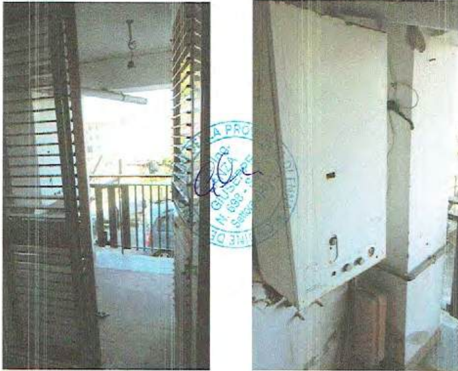
Foto n.17 - Terrazzino di Accesso dal Vano Cucina
