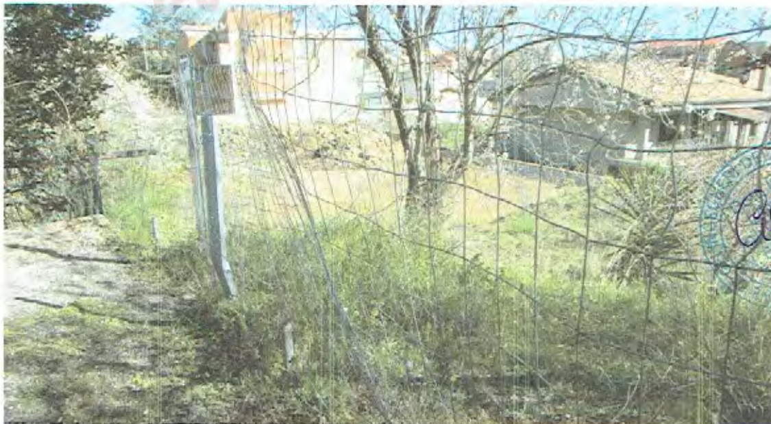
Foto n.44 - Recinzione della U.I. (Lato Ovest)
