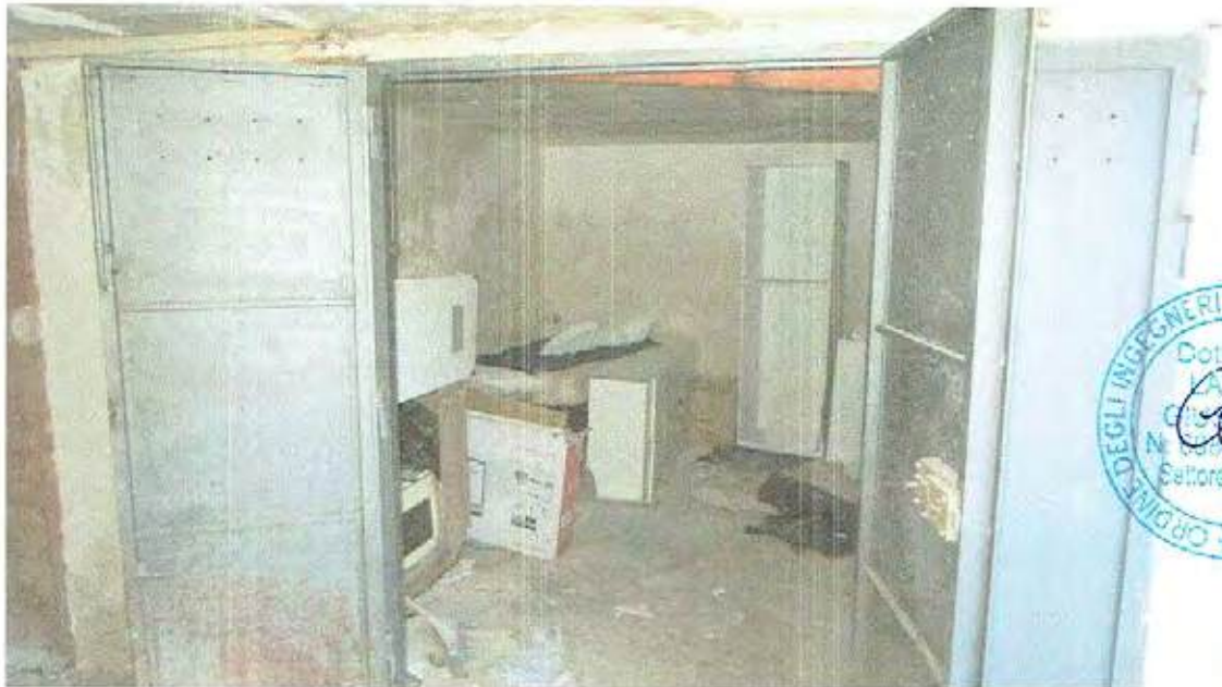
Foto n.33 - Unità Immobiliare n.3 (Piano S2 - Interno garage )
