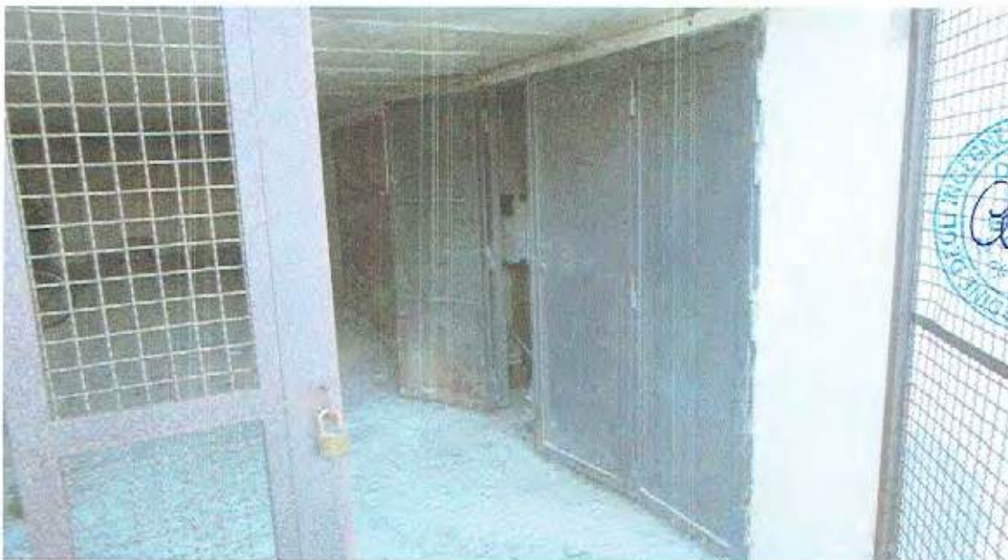
Foto n.32 - Unità Immobiliare n.3 (Piano S2 - Entrata Garage )
