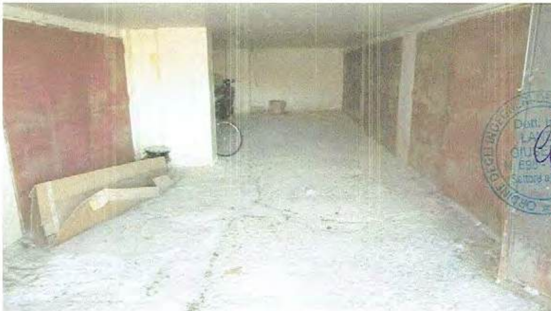
Foto n.31 - Corridoio di Manovra (Piano S2 - di Entrata alle U.I.)
