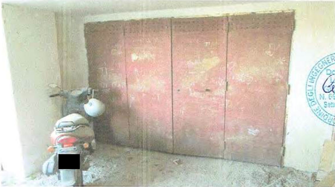
Foto n.39 - Unità Immobiliare n.6 (Piano S2 - Entrata Garage)
