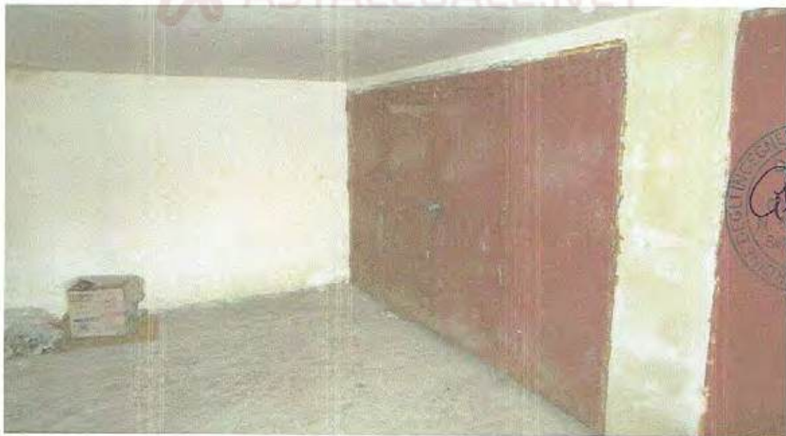
Foto n.34 - Unità Immobiliare n.4 (Piano S2 - Entrata Garage )
