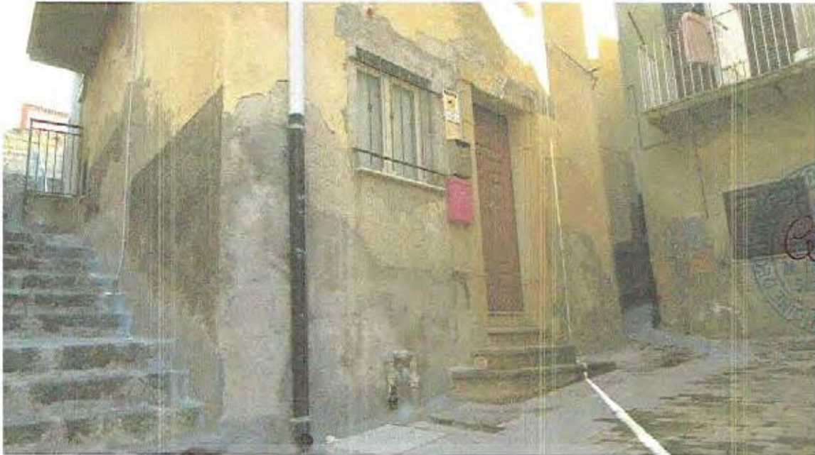
Foto n.14 - Prospetto Sud (Piano Terra - Entrata)
