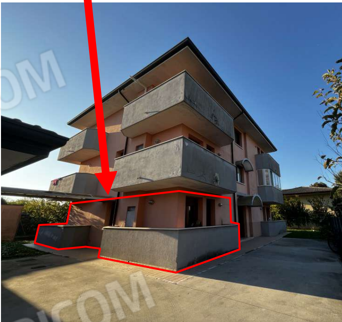
prospetto principale lato Sud – Est
