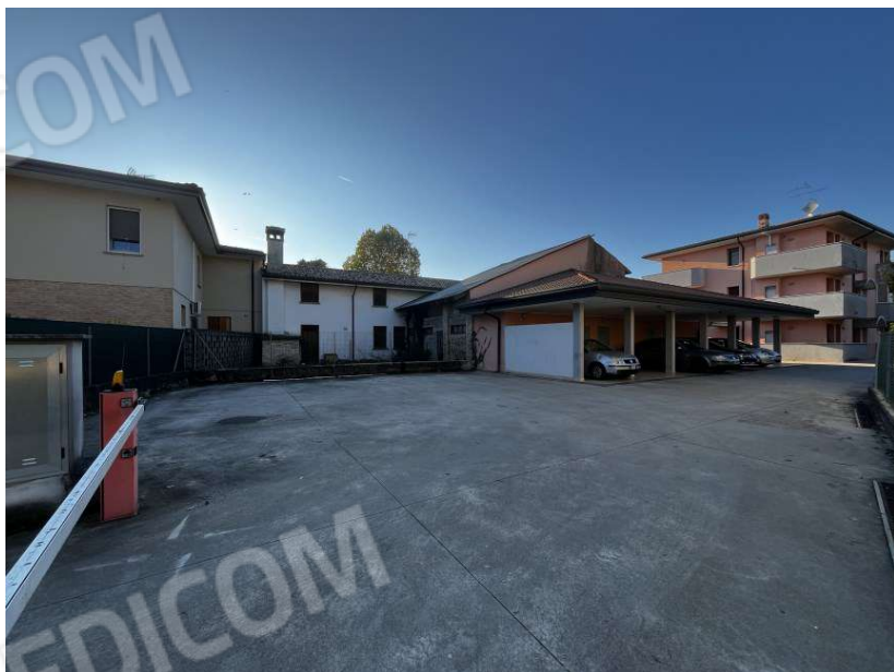
ulteriori viste cortile e giardino ad uso comune
