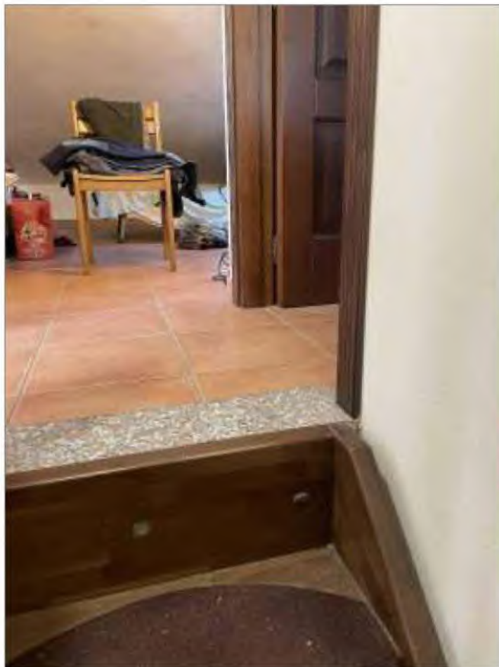
FOTO 3 - Scala a chiocciola - sbarco al piano sottotetto
