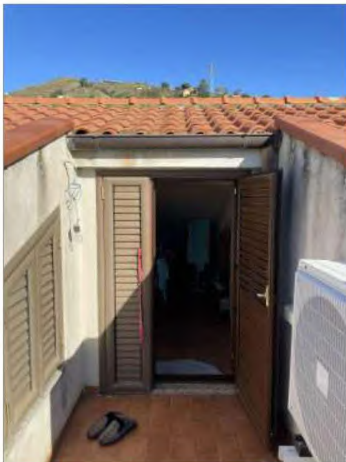
FOTO 18 - Vista della porta finestra dal Terrazzo
