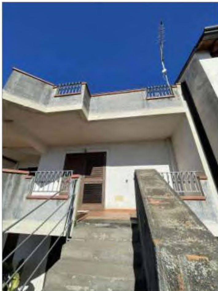
FOTO 3 - Scala esterna verso sbarco al piano 1°
