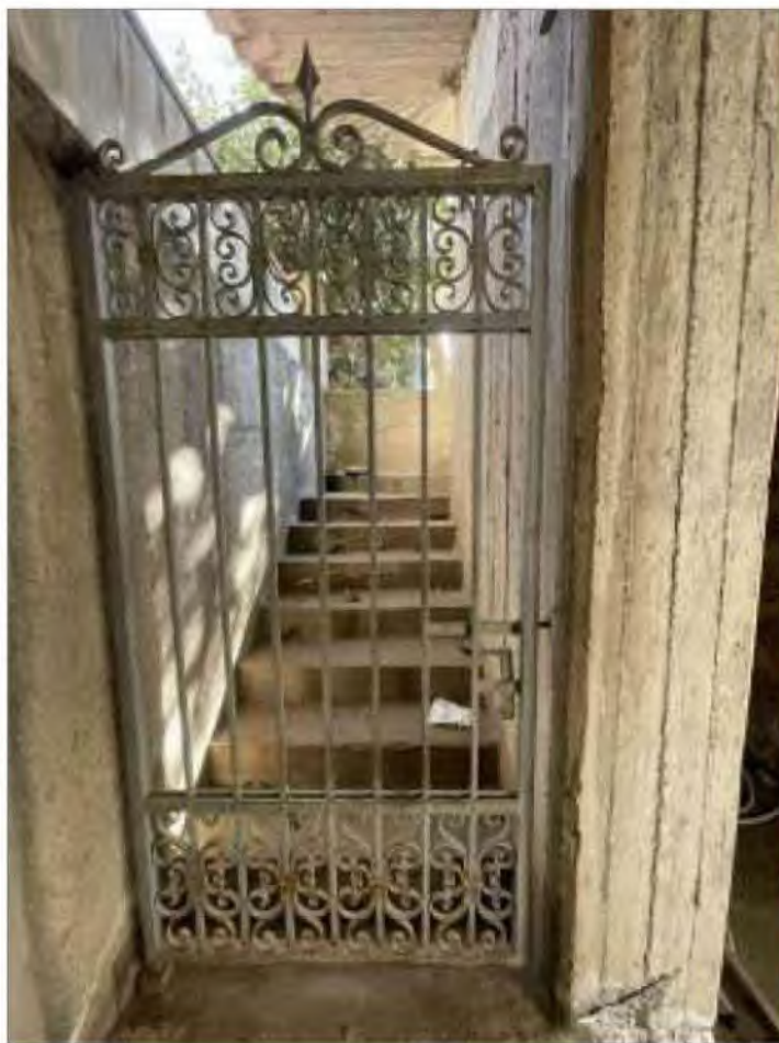
FOTO 2 - Cannello di accesso alla scala
