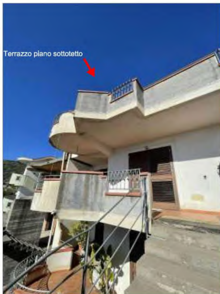
FOTO 4 - Scala esterna e sbarco al piano 1°
