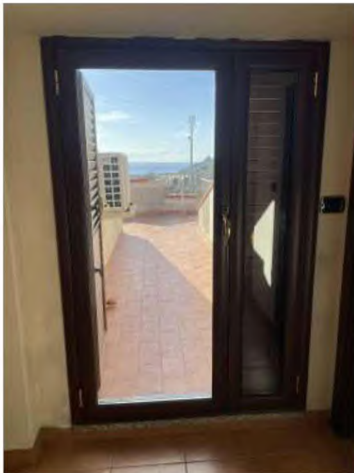
FOTO 17 - Disimpegno verso il Terrazzo
