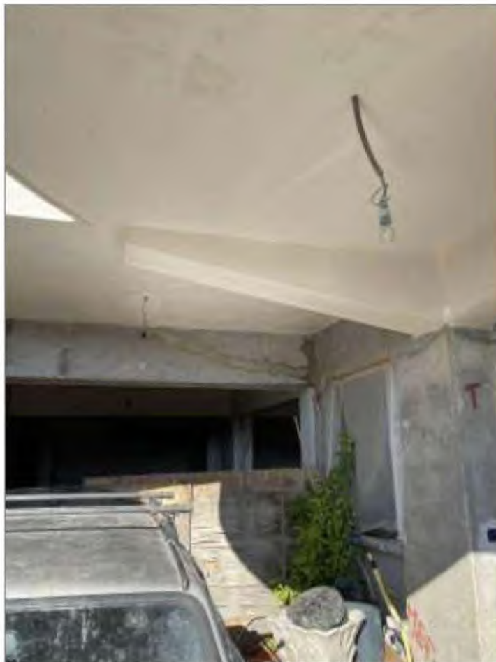
FOTO 5 - Ingresso carrabile al seminterrato
