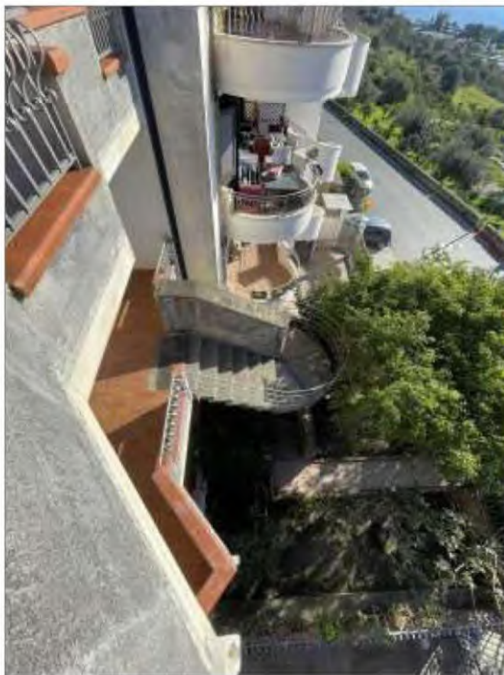
FOTO 12 - Corte antistante e scala esterna di collegamento verticale
