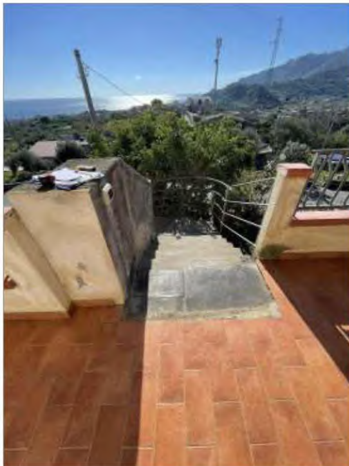
FOTO 5 - Vista da Balcone 2 verso la scala esterna
