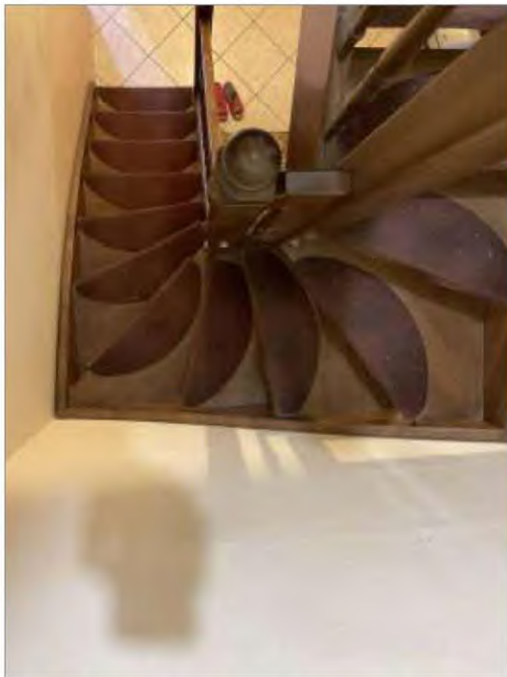
FOTO 1 - Scala a chiocciola di collegamento col piano 1°
