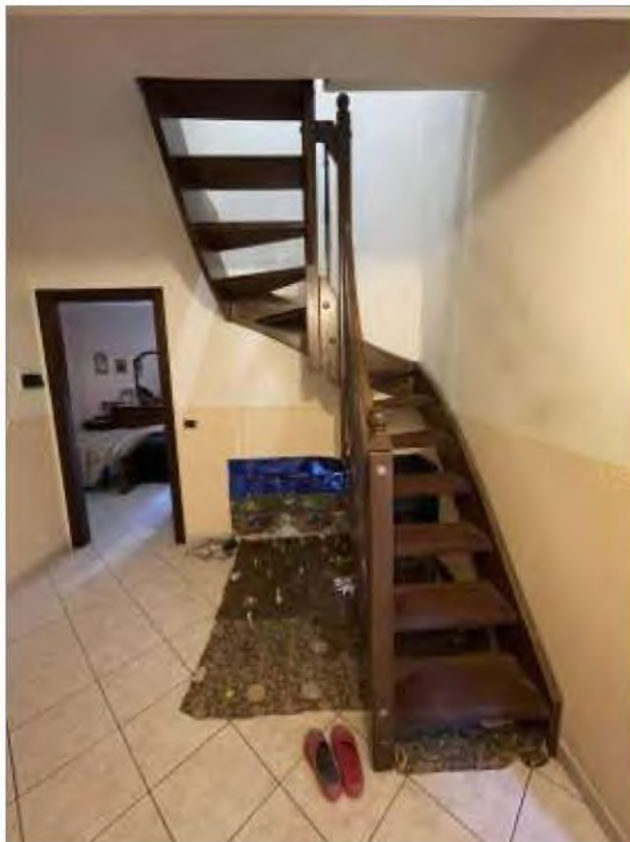
FOTO 23 - Scala lignea di collegamento al piano sottotetto
