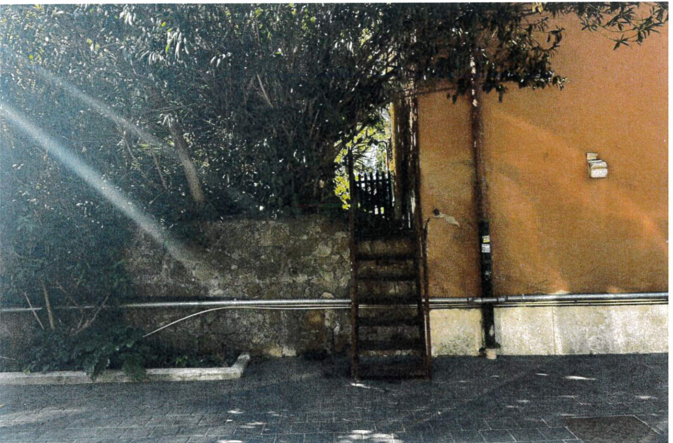
Scale di accesso dalla p.Illa 70 sub.502, ai giardini di proprietà di terzi
