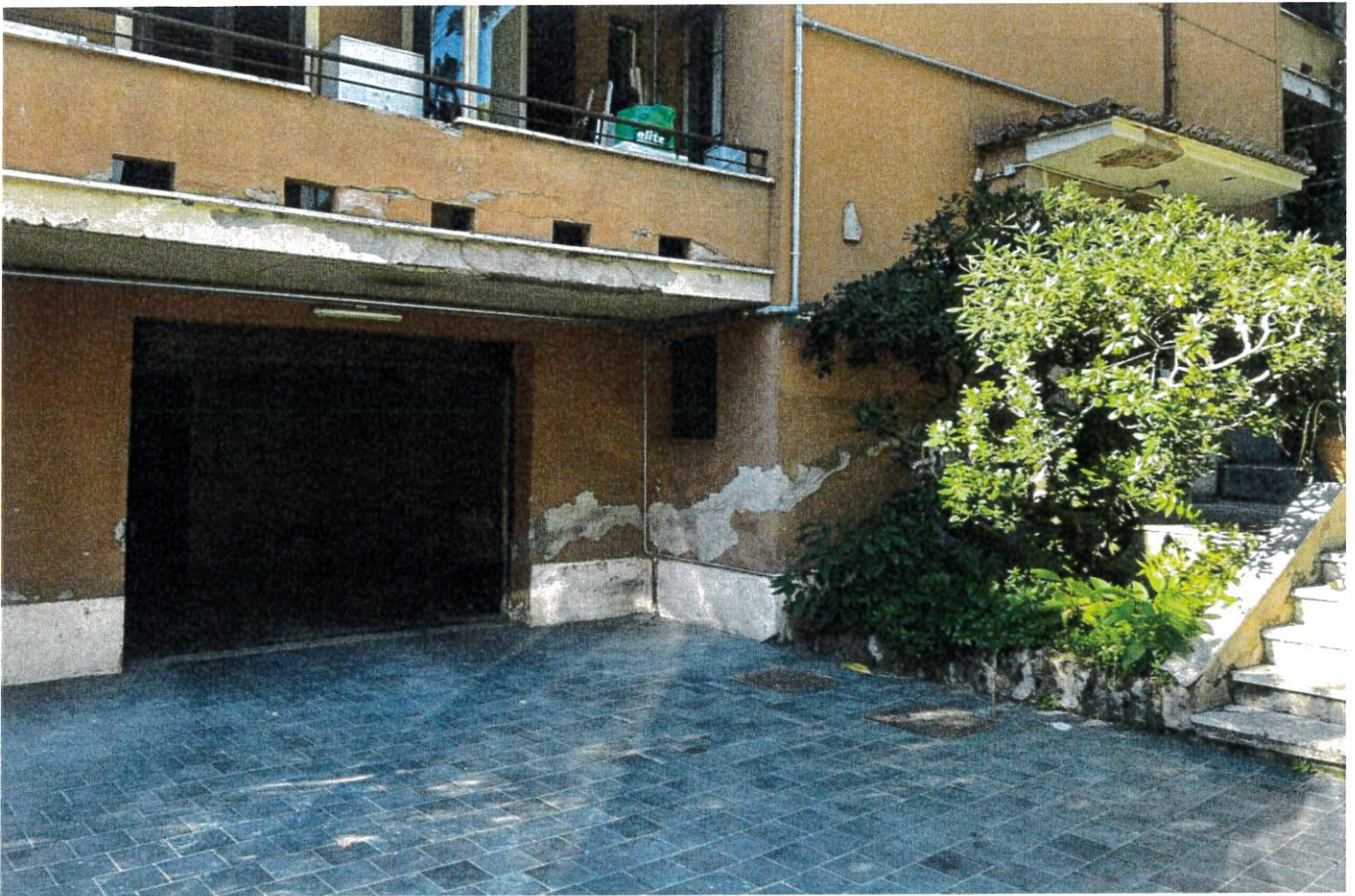
Accesso all'autorimessa facente parte della particella 106, dalla p.Illa 70 sub.502
