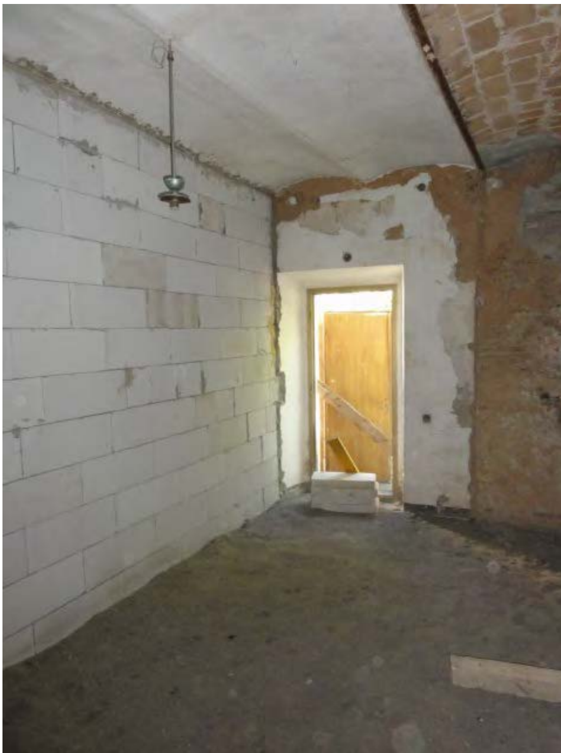
Piano secondo dall'interno verso l'esterno porta ingresso sub.7 (appartamento in progetto n.3)
