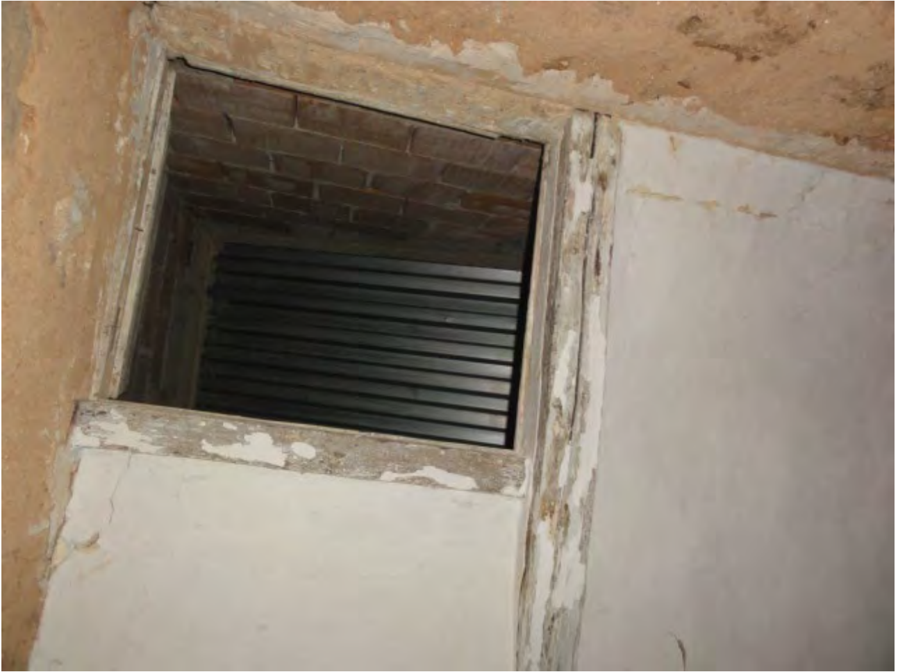
Vista verso l'alto botola nel soffitto si intravede intradosso copertura in lamiera grecata
