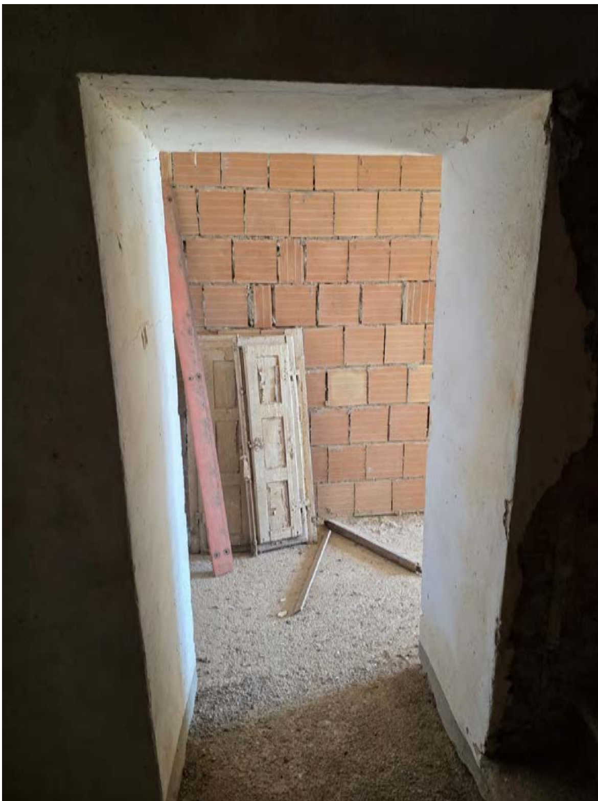
Pianerottolo arrivo al piano primo porta ingresso appartamento sub.10 (interno n.2 progetto)
