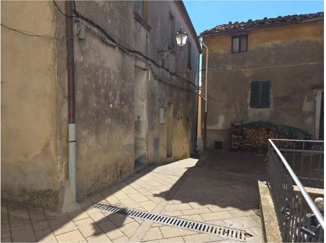
Via IV Novembre (spigolo a monte dell'edificio)
