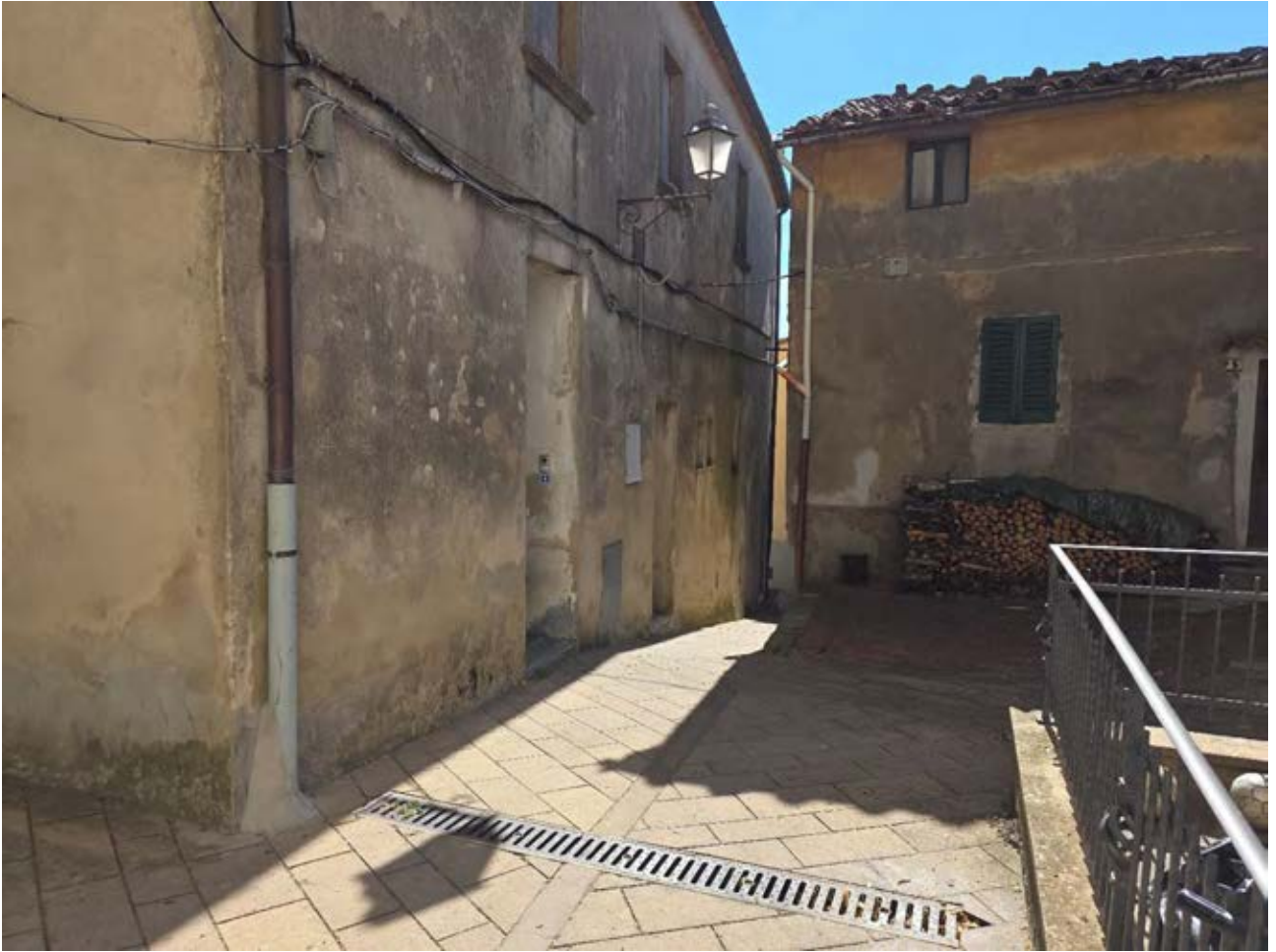
Via IV Novembre (spigolo a monte dell'edificio)
