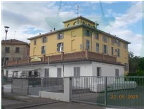
fronti sud ed est fabbricato
