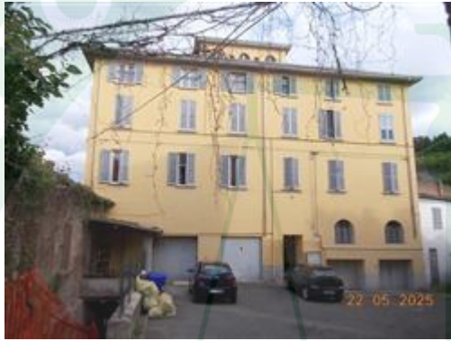
fronte ovest fabbricato
