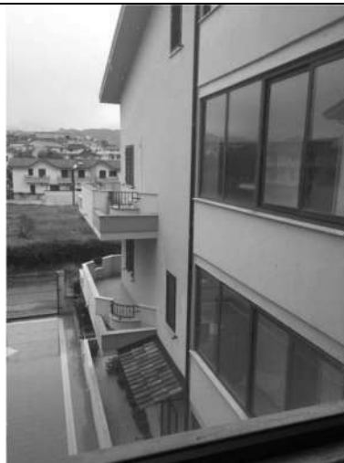
Ballatoio con vista lato nord
