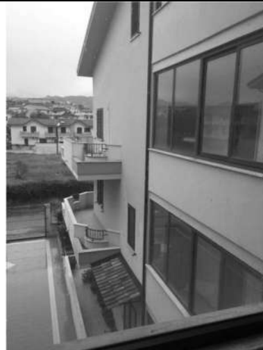
Ballatoio con vista lato nord
