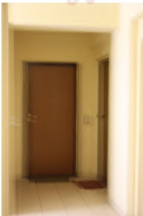
Pianerottolo piano secondo e ingresso subalterno 28
