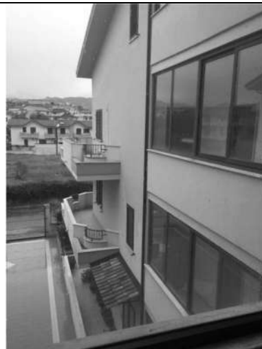
Ballatoio con vista lato nord
