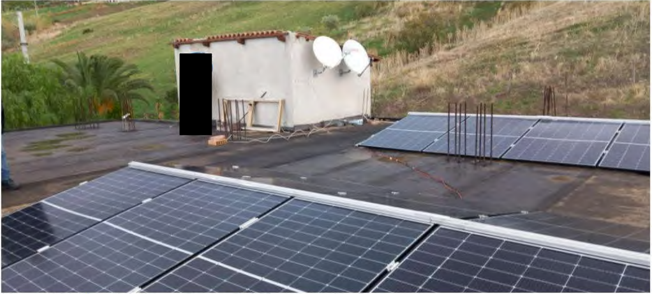
Figura 18: vista del piano primo, sub 4 (lastrico solare)
