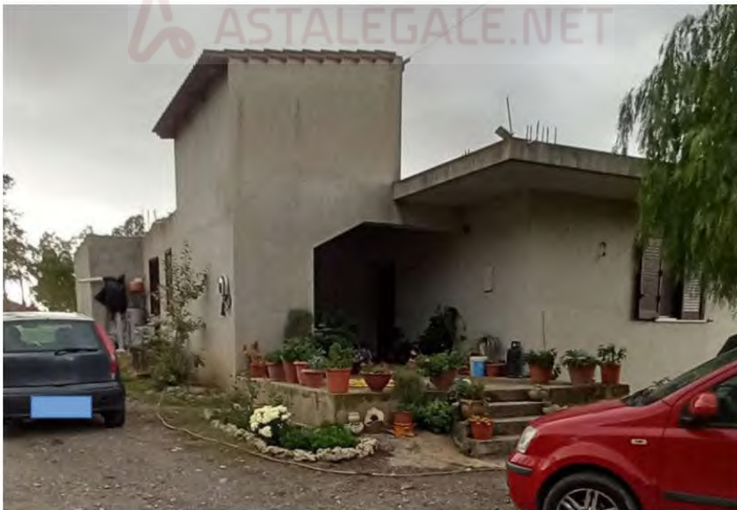
Foto 4: vista esterna del cespite ingresso scale pianerottolo (lato nord - est)
