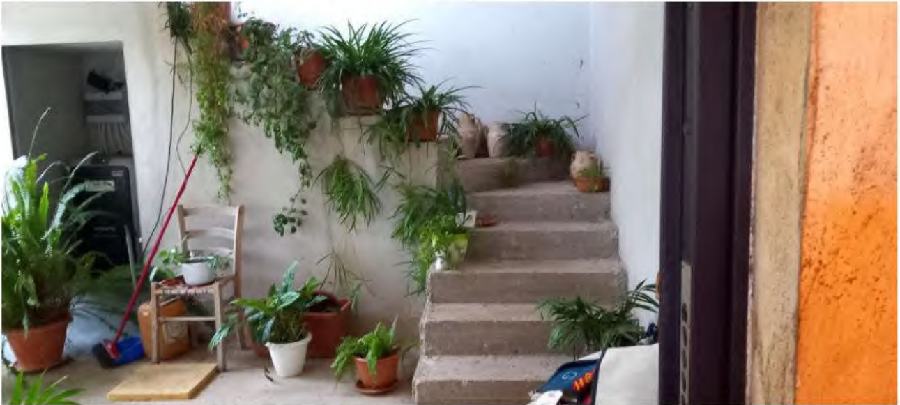
Figura 16: vista del vano scale che conduce al piano primo, sub 4 (lastrico solare)16
