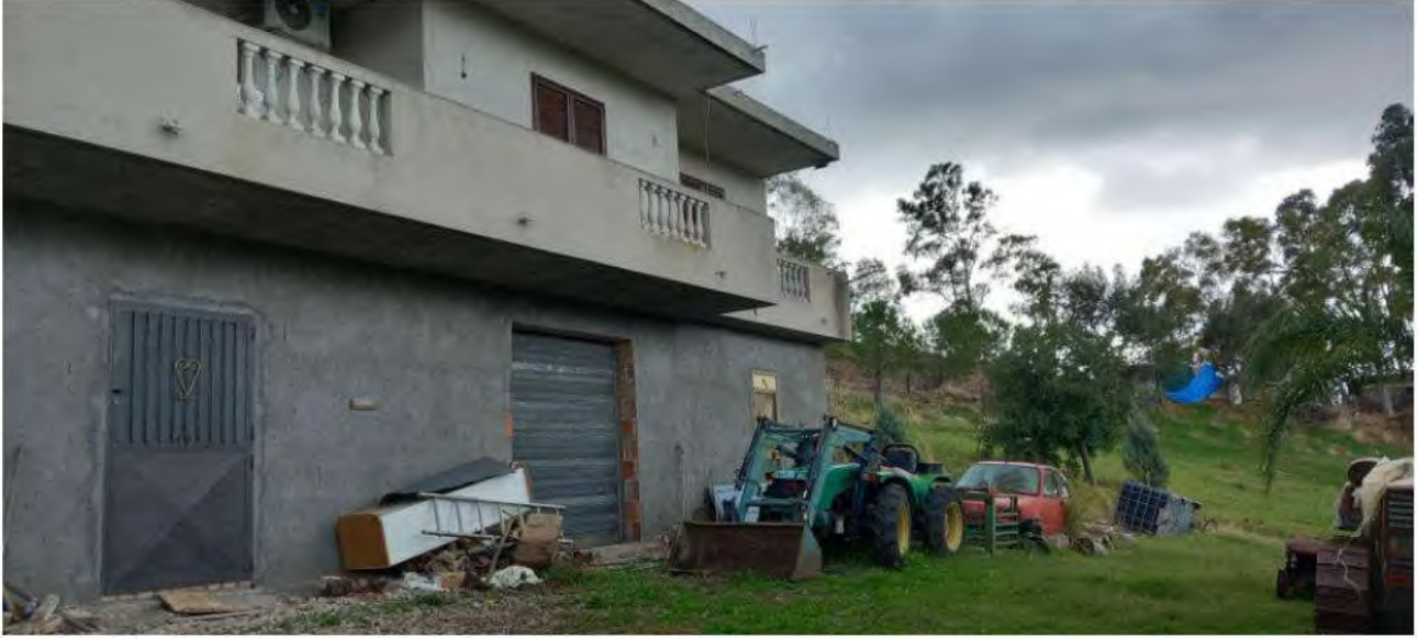
Figura 19: vista esterna del piano seminterrato (sub 3)
