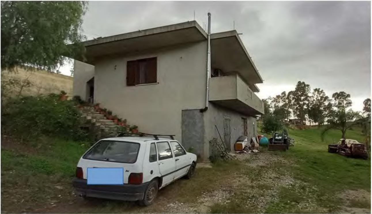
Figura 5: vista esterna del cespite lato nord - ovest
