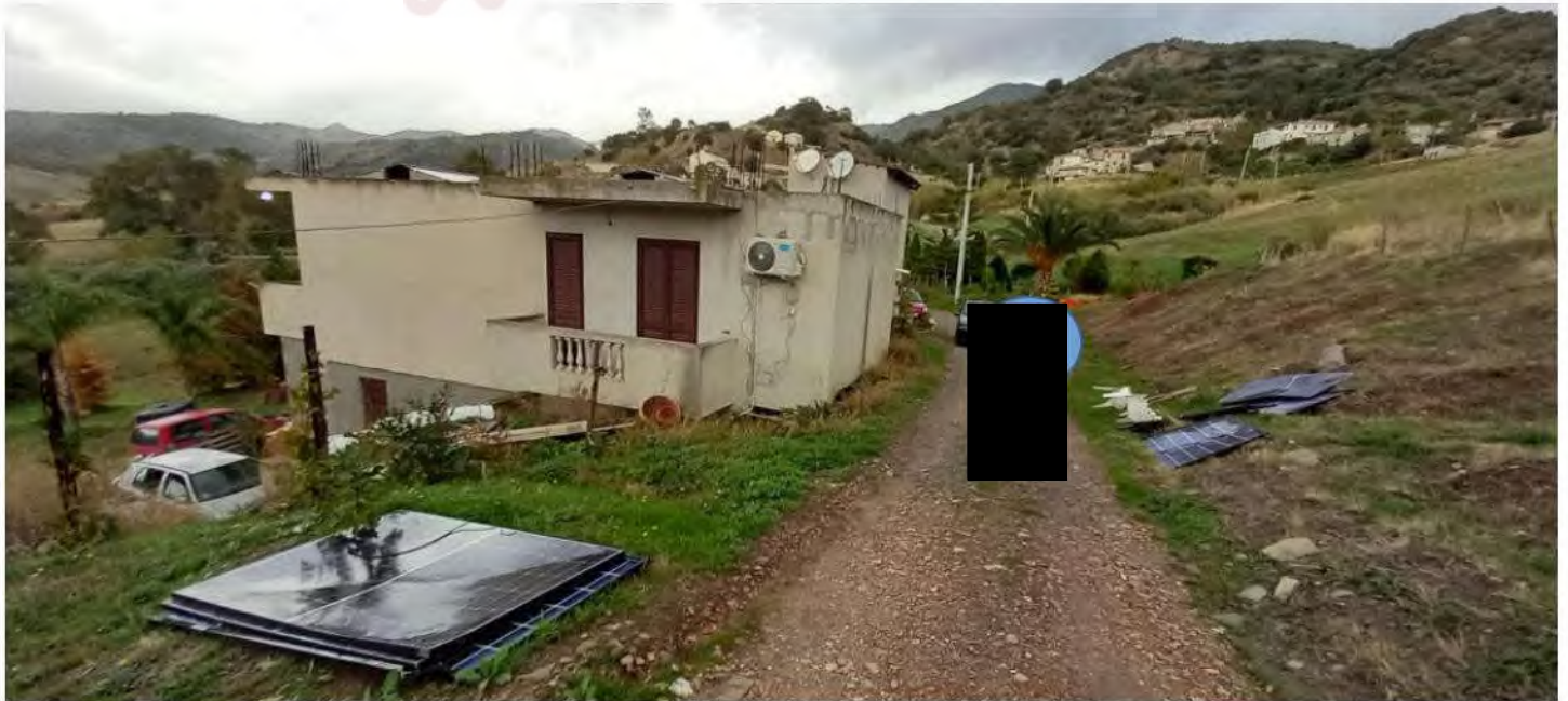
Figura 6: vista esterna del cespite lato sud - est
