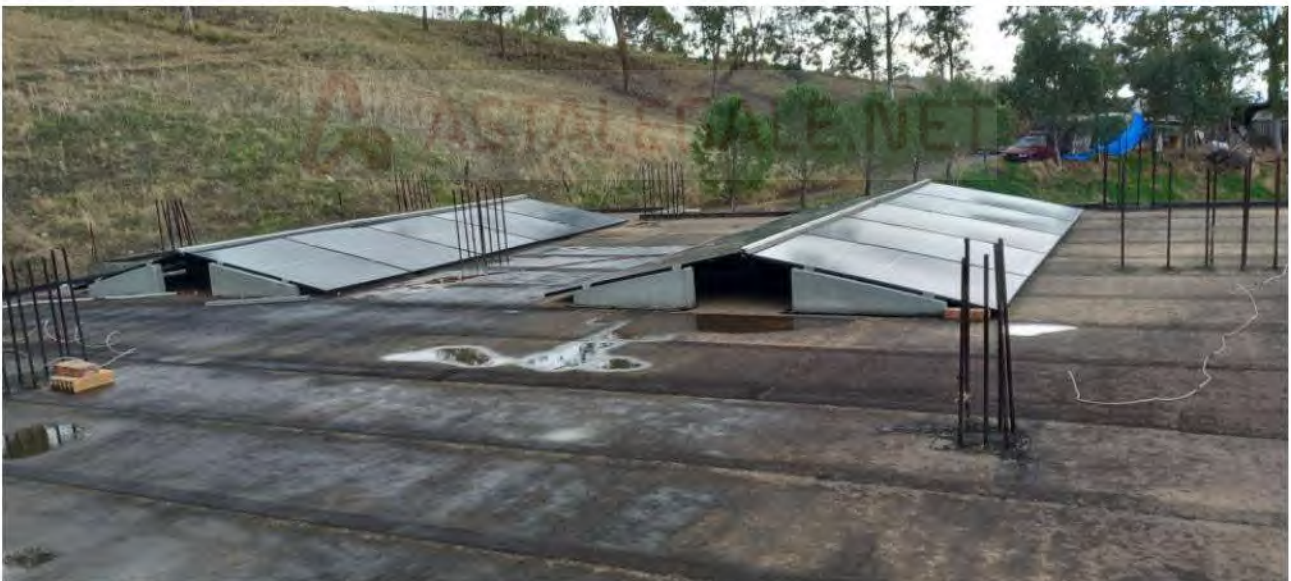
Figura 17: vista del lastrico solare, sub 4
