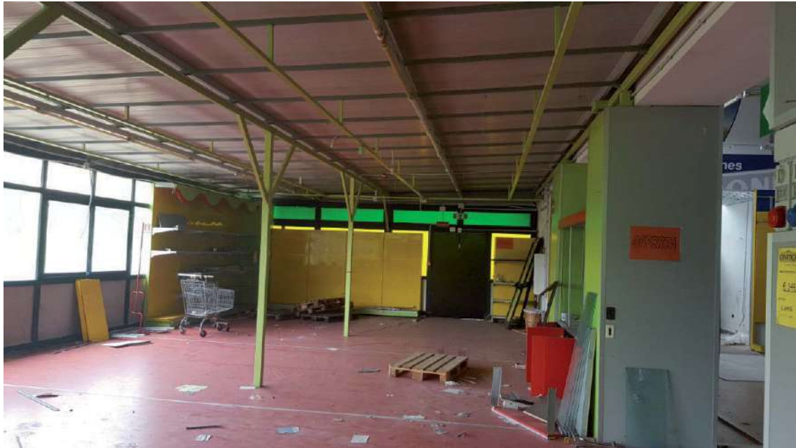
INTERNO LATO OVEST (AREA DA REGOLARIZZARE)
