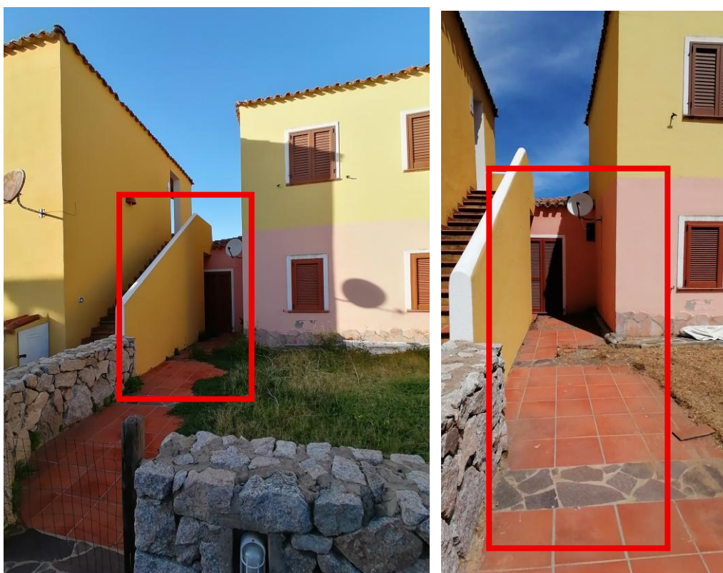
Cono A1 e Cono A2 – l'accesso al lotto dal lato sud, verso la camera da letto
