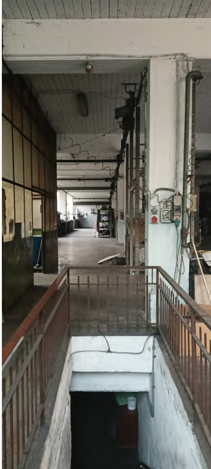
03 – Scala interna di collegamento fra il piano seminterrato e interrato
