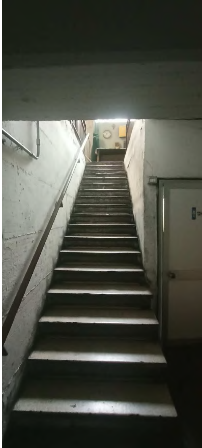
17 – Scala interna di collegamento fra il piano seminterrato e interrato
