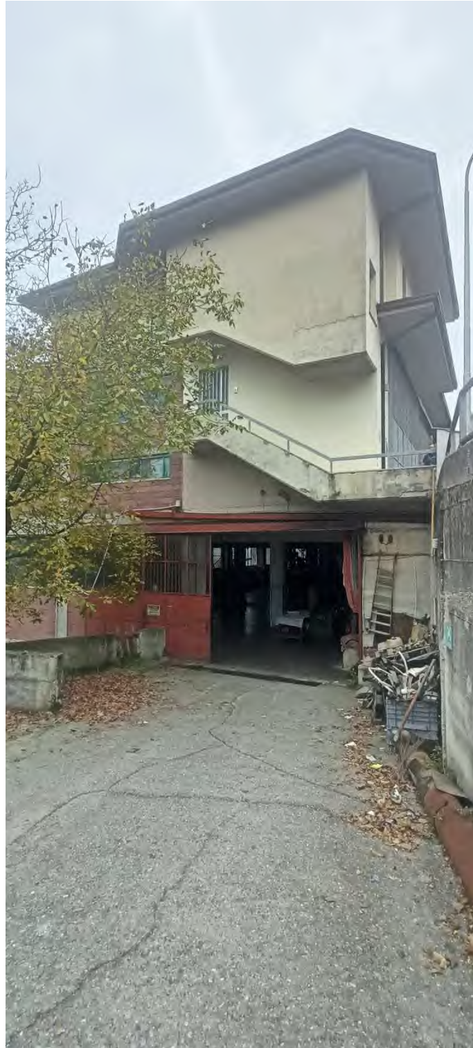
01 – Rampa di accesso ed entrata
