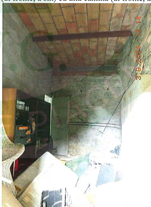
Interno del vano cantina a dx
