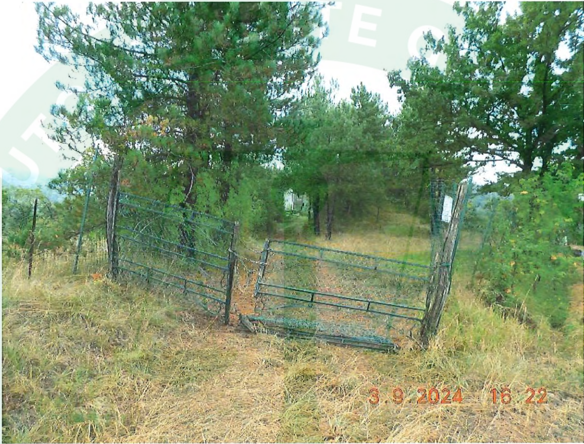
Cancello di ingresso alla rampa lato est, con accesso dalla SS62 della Cisa
