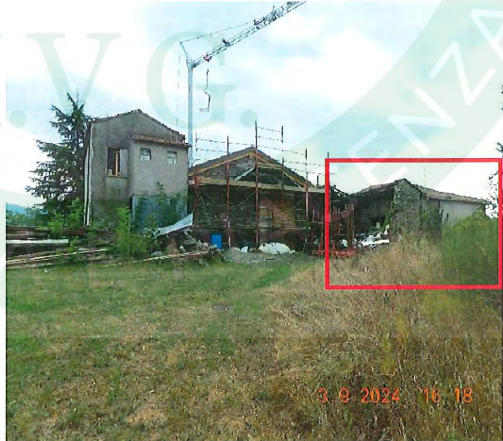
Arrivo della rampa ai locali deposito sovrastanti l'u.i. abitativa
