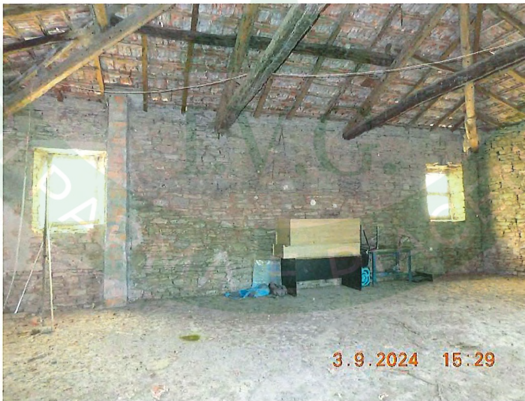
Locale di deposito sovrastante l'unità abitativa
