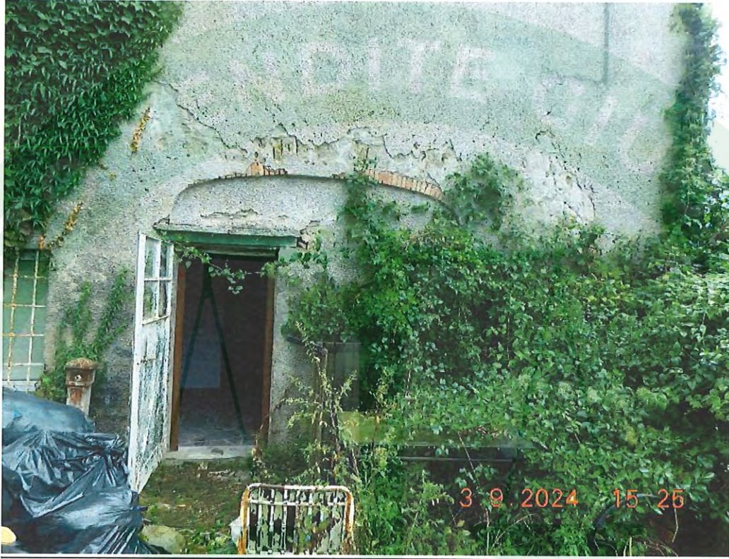
Area cortilizia lato est adiacente l'unità abitativa
