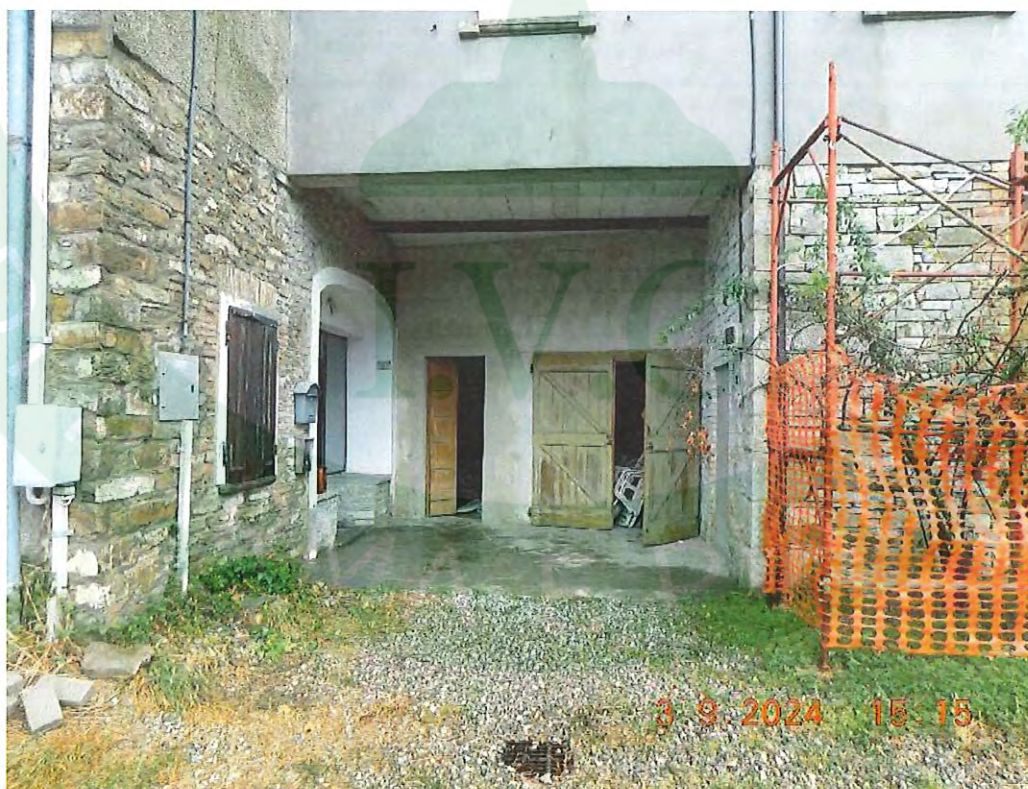
Portico di ingresso dalla strada statale all'unità abitativa con accesso a ripostiglio e cantina lato nord
