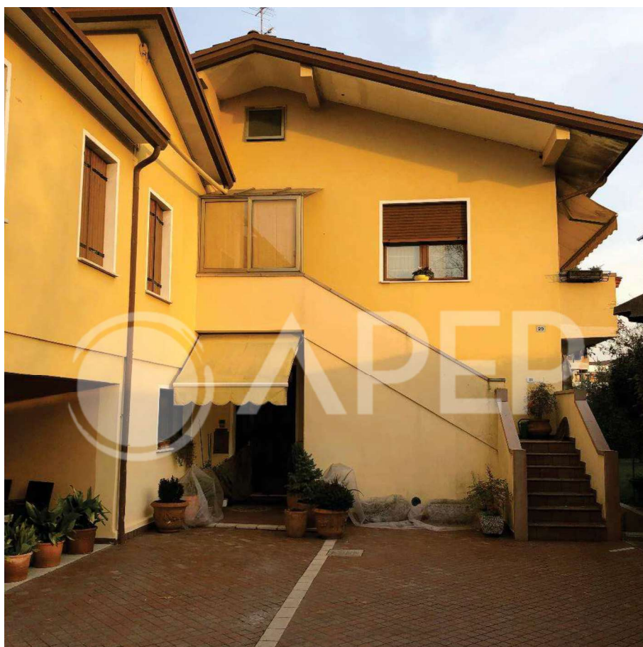
foto n. 2 – facciata ovest del fabbricato
