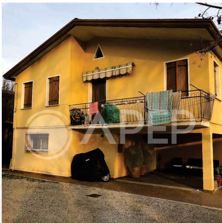
Figura 20 – Porzione della facciata ovest del fabbricato (sub. 2)
