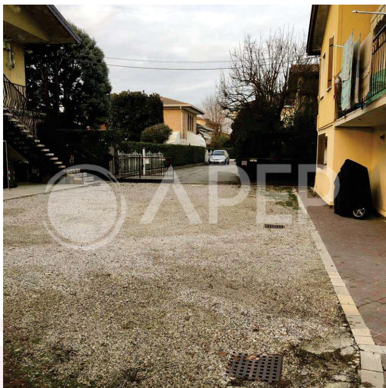
Figura 23 – Cortile utilizzato in forma promiscua dai due fabbricati
