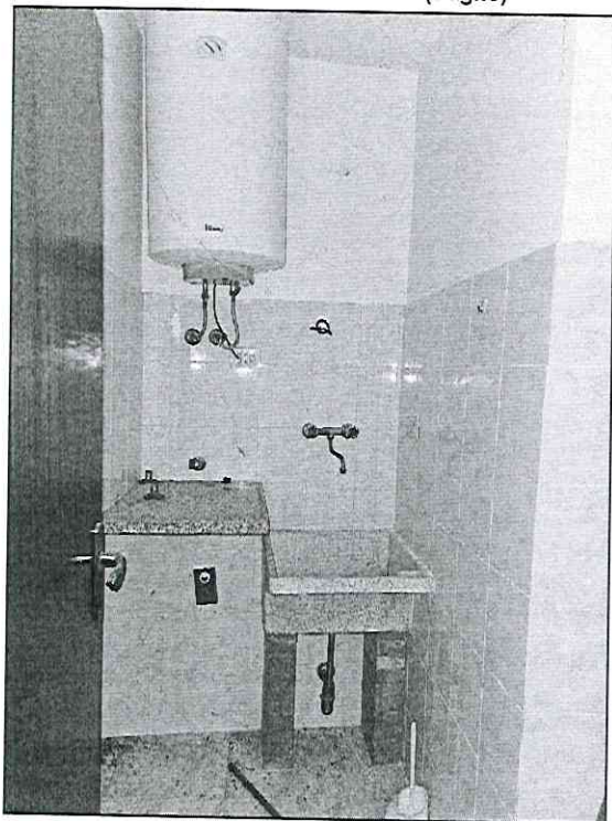
FOTO 9 - Piano Terra - Interni (Bagno)
