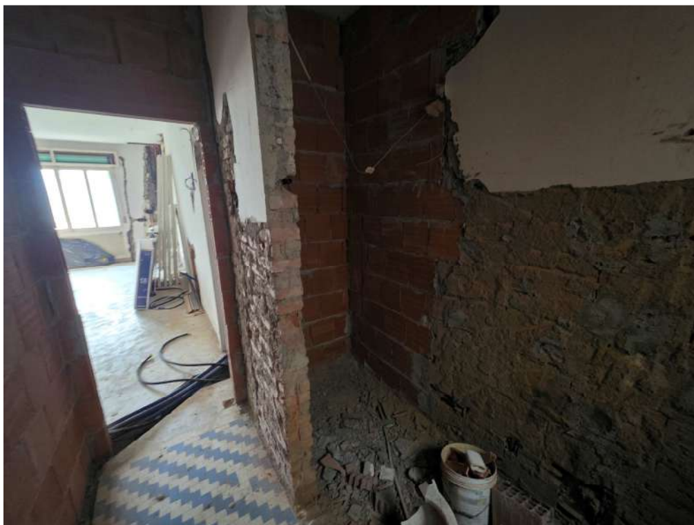
Foto 3: Bagno - Piano terra
