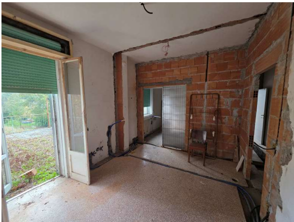
Foto 5: camera – piano primo
