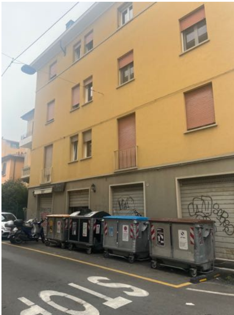
Vista dell'edificio di Via Andrea da Faenza n. 48/A-B a Bologna dalla strada. Le vetrine sono le ultime due.
