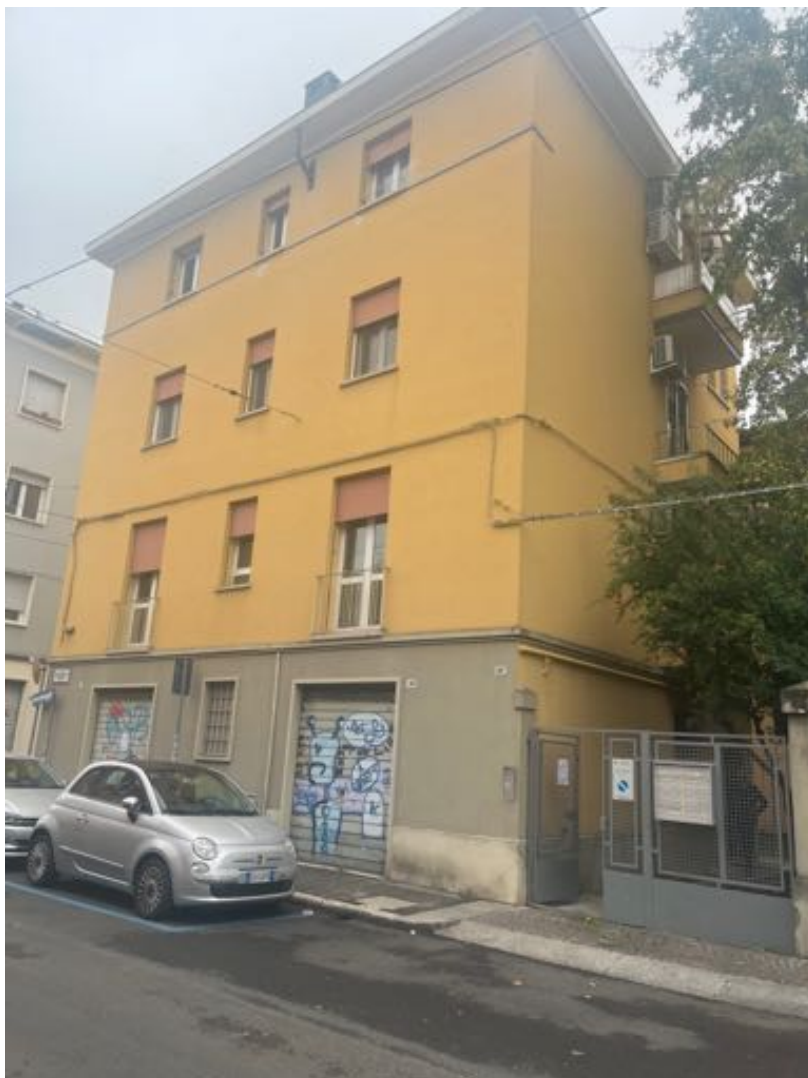
Vista dell'edificio da Via Barbieri. L'accesso pedonale del n. 18/2 conduce al vano scale ed al corridoio cantine..
