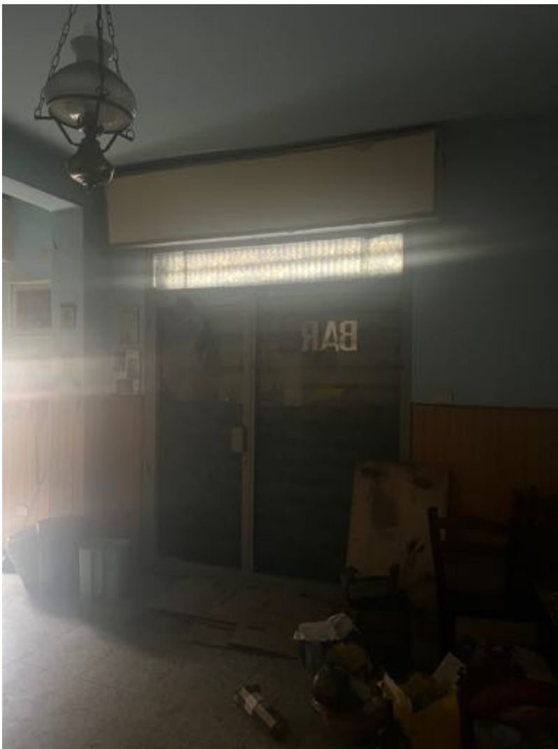
Vista del vano principale di vendita verso una delle vetrine
