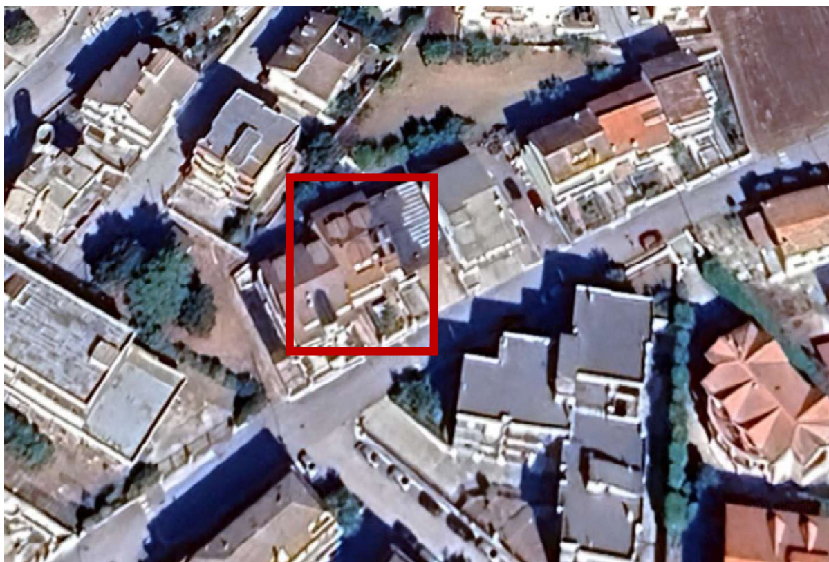
Figura 5 – Foto aerea con individuazione del complesso immobiliare.
