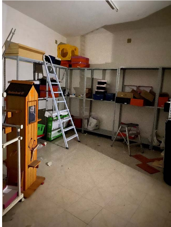
Figure 11 – Vano piano primo particella 373
