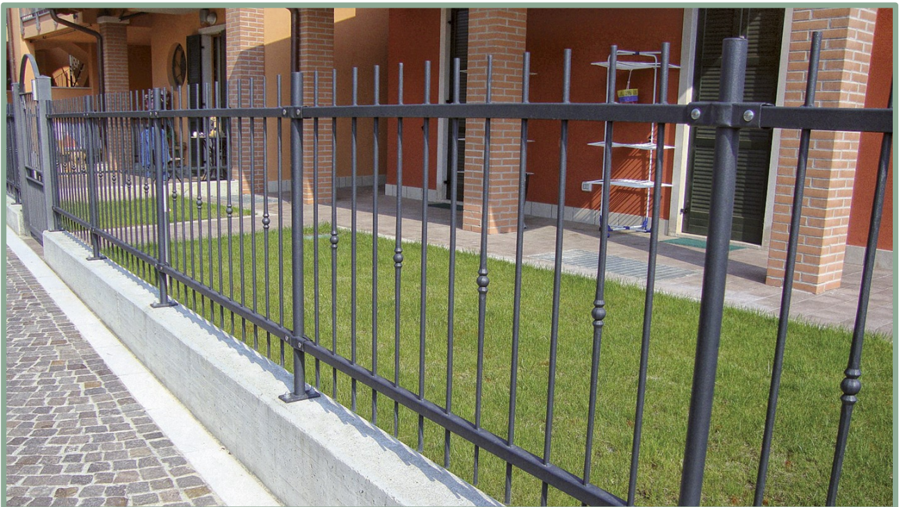
Esempio recinzione lungo strada pubblica con cordolo in cemento e soprastante cancellata in metallo
