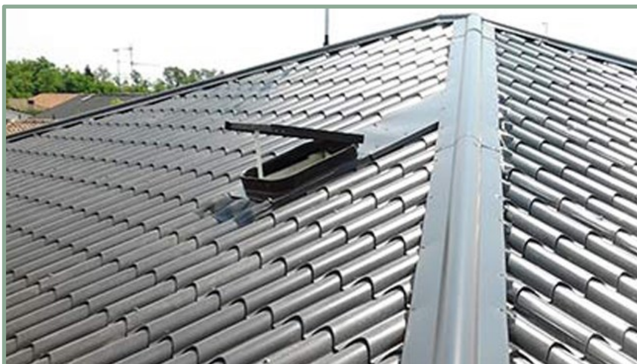
Esempio di copertura realizzata con pannelli coibentati effetto finto coppo.
