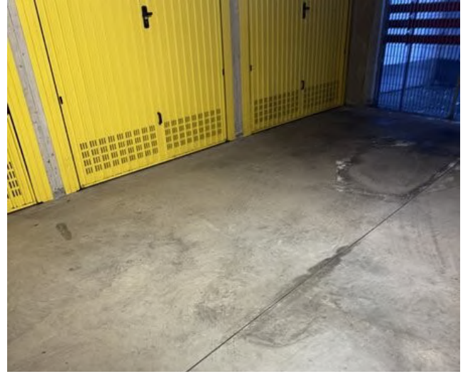
Area di manovra
