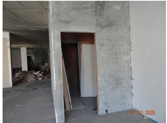
Ingresso anti bagno e wc
