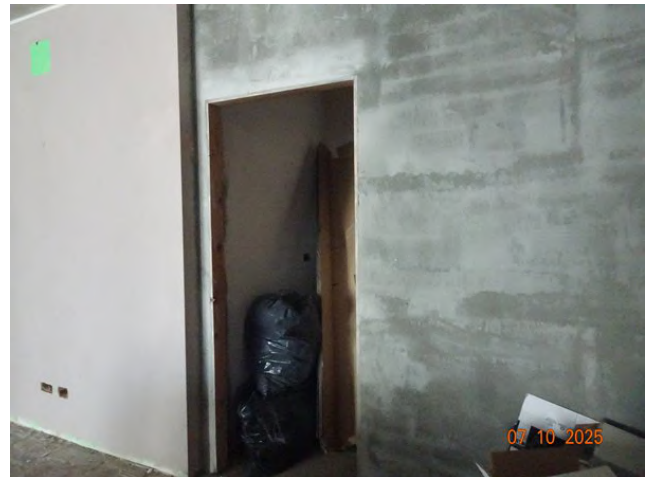
Ingresso anti bagno e wc
