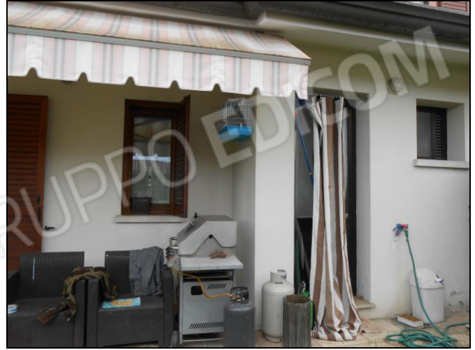
22) Finestra cucina e porta lavanderia
