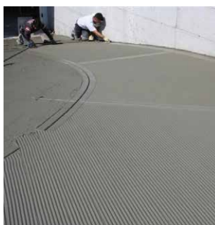
D1 - d _ Rampa corsello
