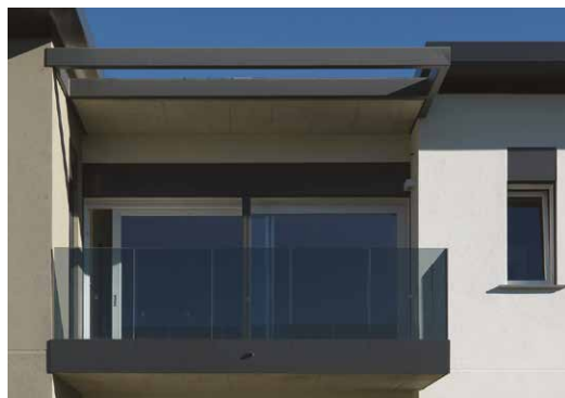
B1 - g _ Balconi con parapetti in vetro
