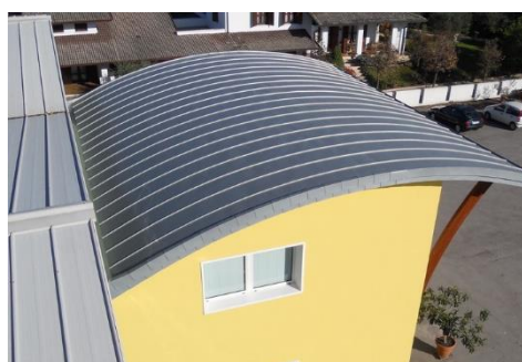
Esempio finitura copertura vano scala
