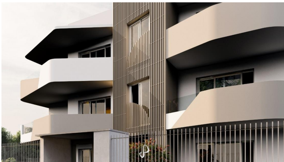
Porzione di facciata rivestita con elementi verticali
