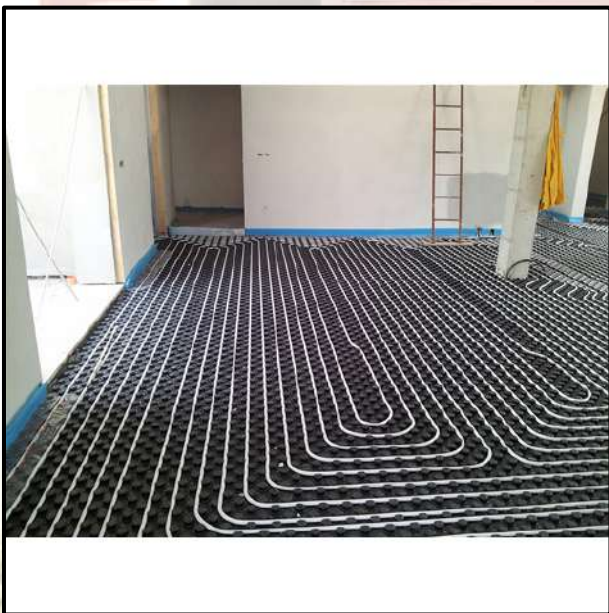
Figura 10: Esempio di impianto di riscaldamento a pavimento
