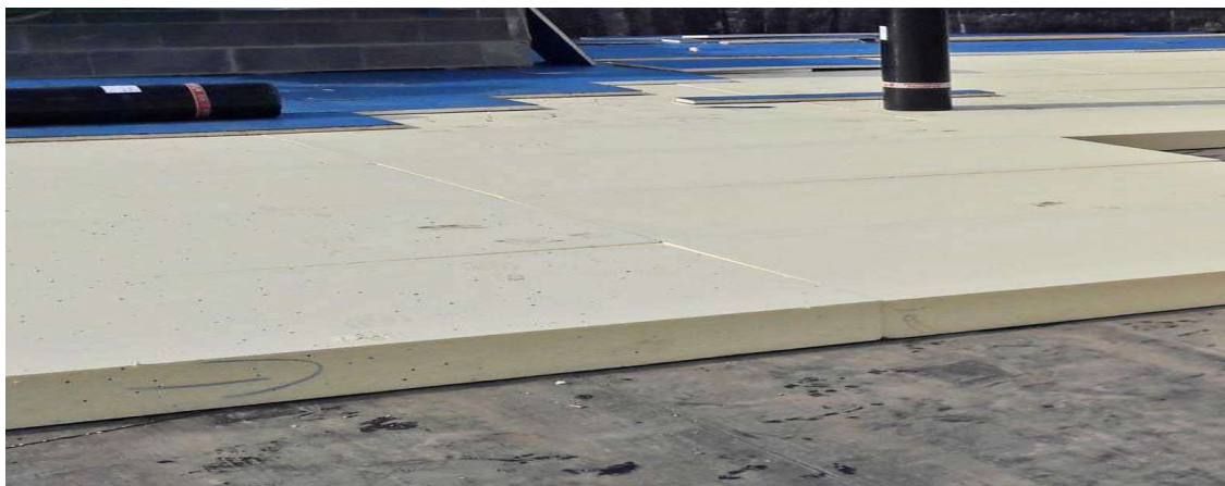
Esempio in copertura piana con isolate
