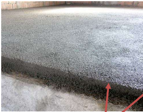
Sottofondo sabbia e cemento
