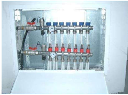
COLLETTORE PANNELLI RADIANTI
