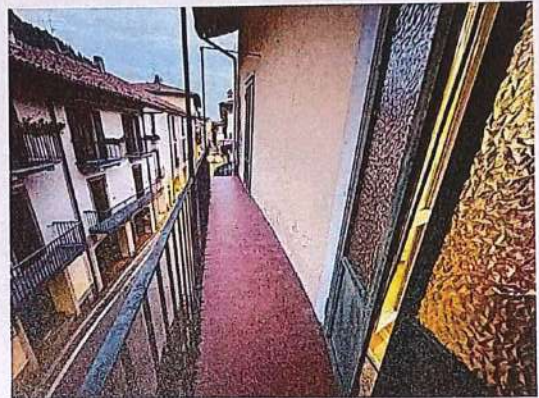
balcone lato nord
