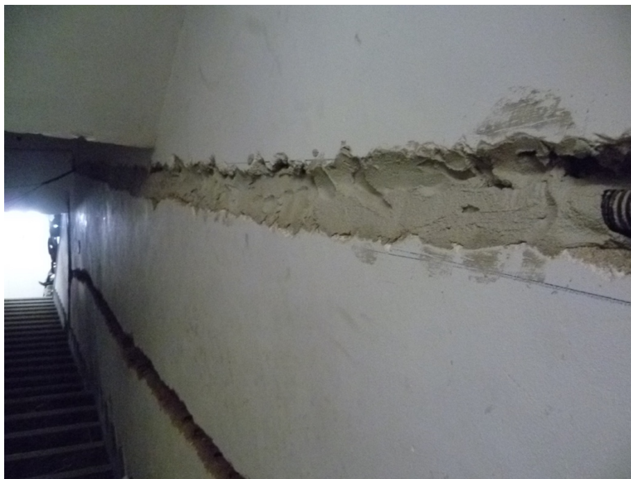
Foto n.02 – Muro del vano scala
