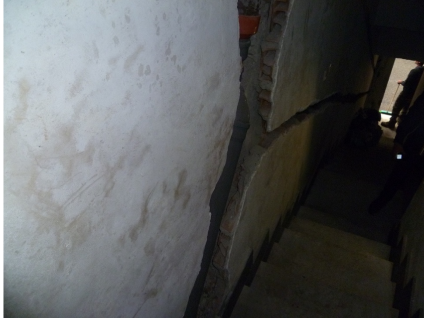
Foto n.05 – Muro vano scala
