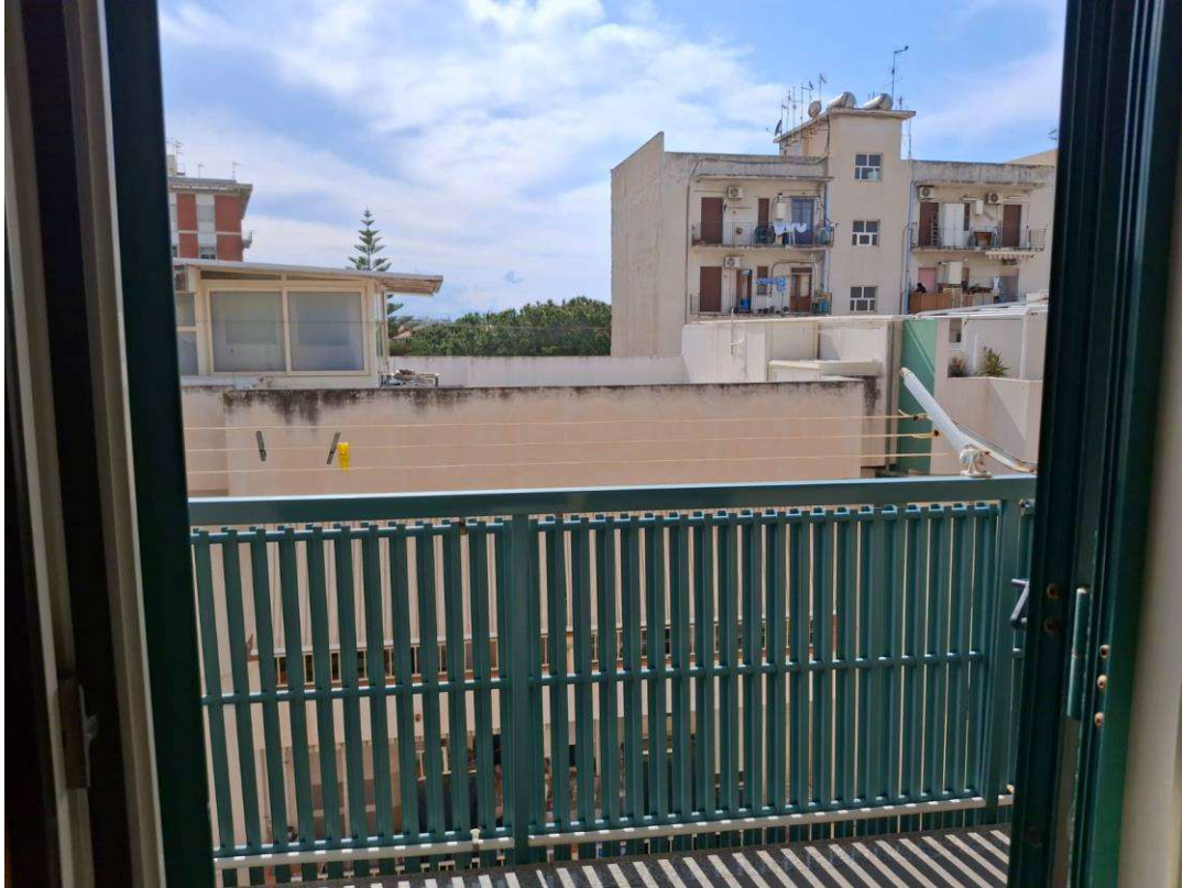
-Foto n.18: Balcone lato Sud-Ovest-
