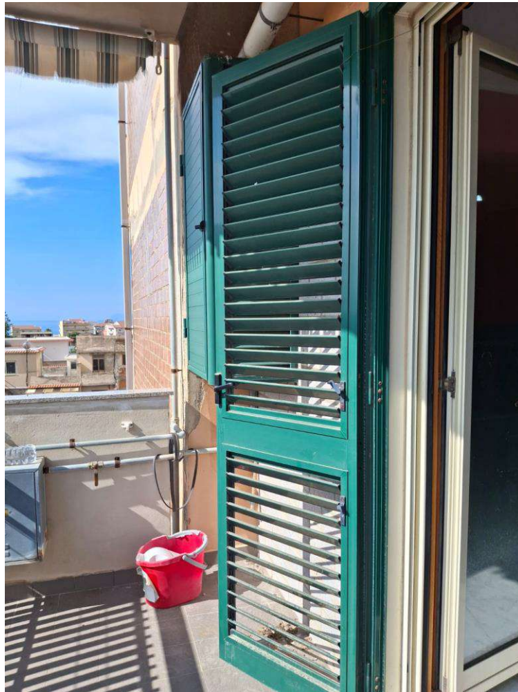
-Foto n.16: Balcone lato Nord-Est-
